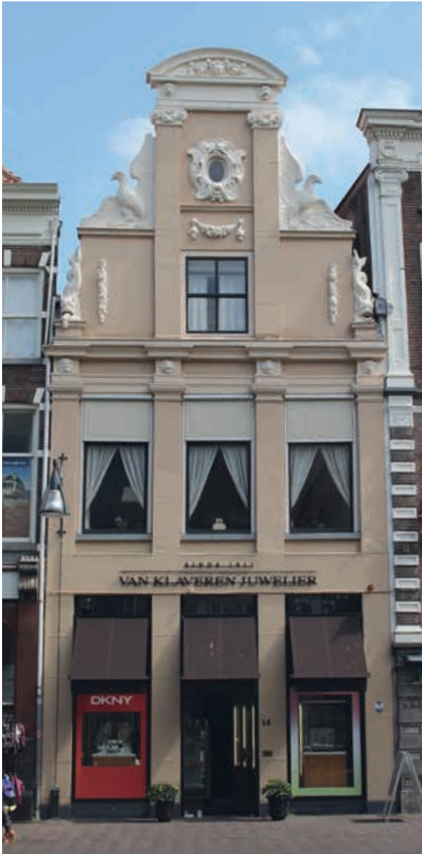
29. Voorgevel van Melkmarkt 14 in Zwolle, 1653, toe te schrijven aan het atelier van Gerrit Lambertsen van Cuilenborch, in opdracht van Ernst van der Marck, secretaris van de Drost van Salland (foto auteur)
