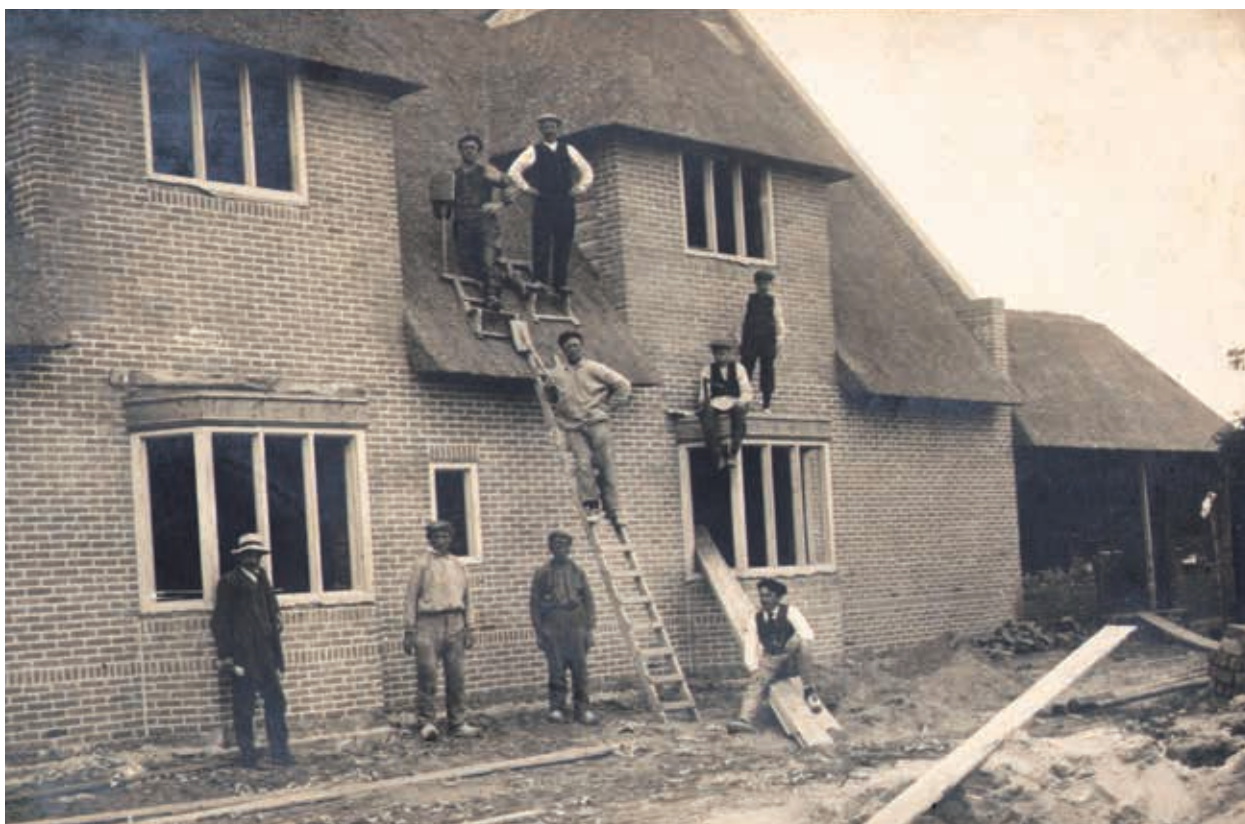
8. Landhuis De Hoeve, bouwfoto, 1913. De rietdekkers leggen de laatste hand aan het dak. Mogelijk is de man links B. van den Nieuwen Amstel, die voor Van 't Hoff toezicht hield op de bouw (particuliere collectie familie Stenfert Kroese)
