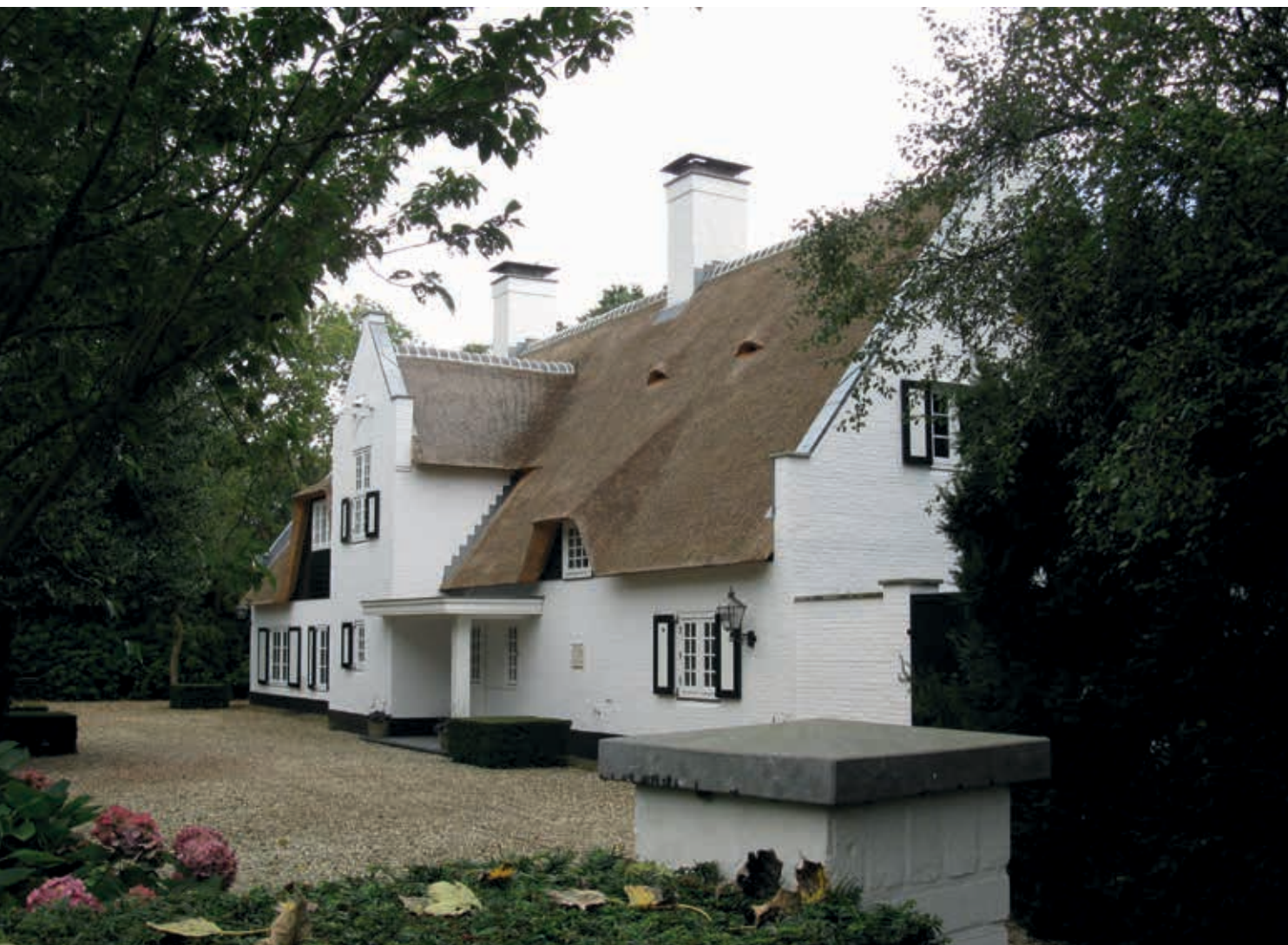
14. Robert van 't Hoff, Landhuis De Hoeve, Noordwijk-Binnen, in 2015. Het gedeelte links van de steekkap is in 1952 bijgebouwd, naar ontwerp van architect W.C. Hamdorff (particuliere collectie Rotterdam)
