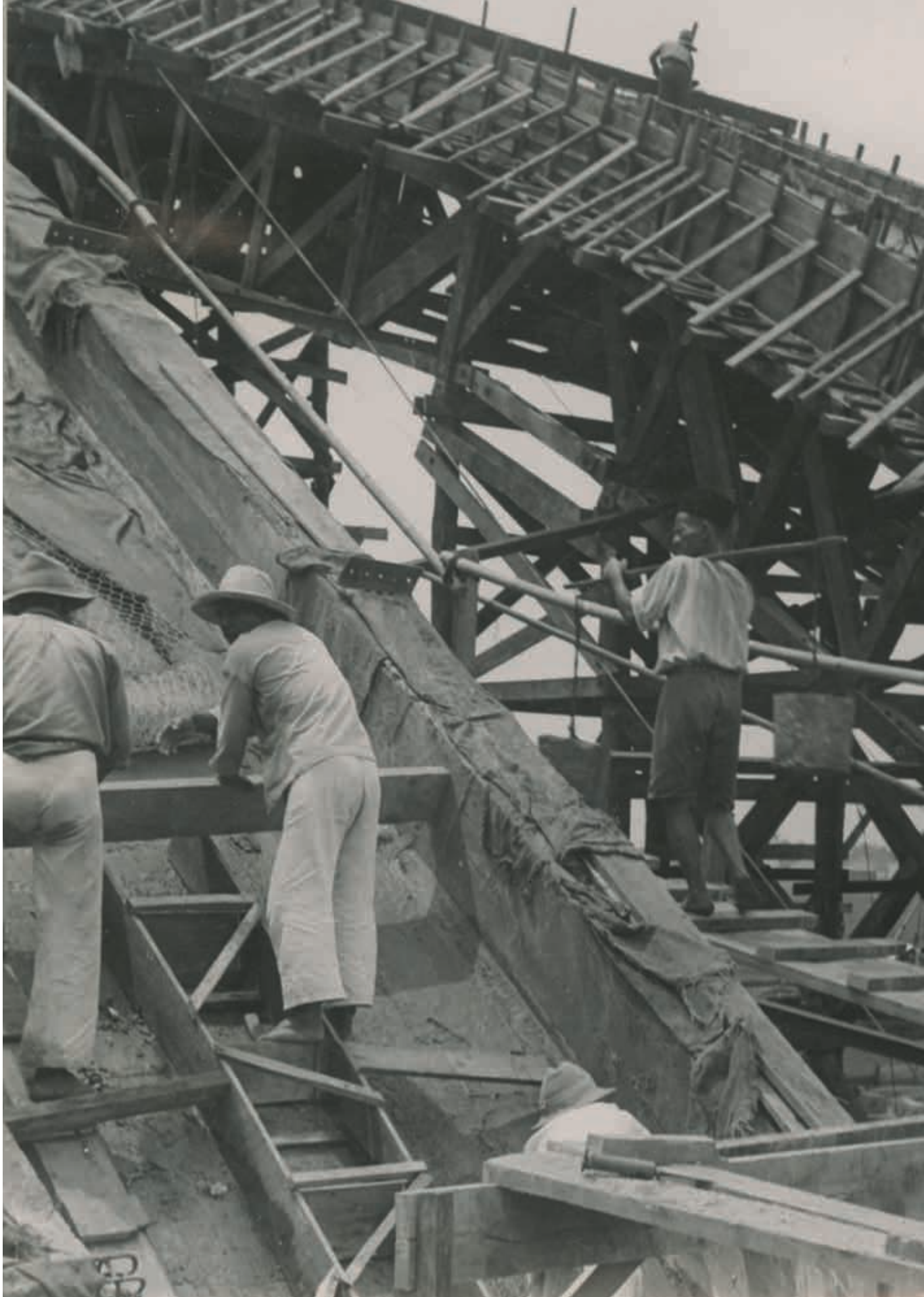
▲ 1. A.W. Gmelig Meyling (ontwerp) en G.S. Vrijburg (constructie), een van de hangars voor de militaire vliegvelden Andir in Bandoeng, Tjililitan in Batavia en Maospati in Madioen 1938-1939, in aanbouw (Het Nieuwe Instituut)
