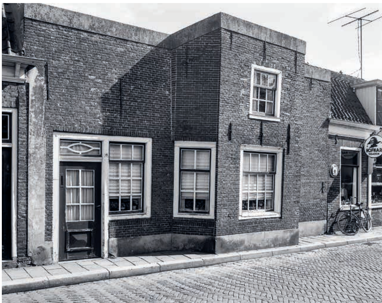
7. De koepel op Vijzelstraat 15 in september 1962, foto G.Th. Delemarre (Rijksdienst voor het Cultureel Erfgoed)
