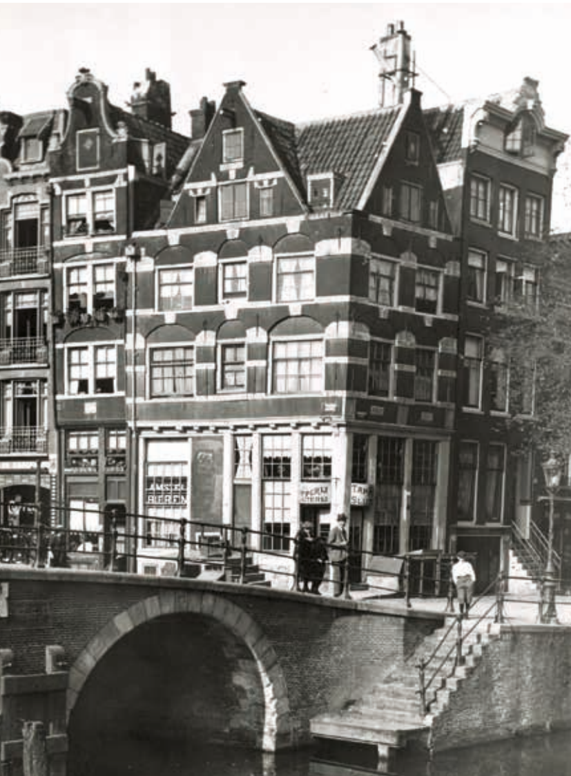
15. Prinsengracht 2, Amsterdam, ca. 1918. Bij een tweede restauratie in 1956 werden de trapgevels gereconstrueerd (Stadsarchief Amsterdam)
