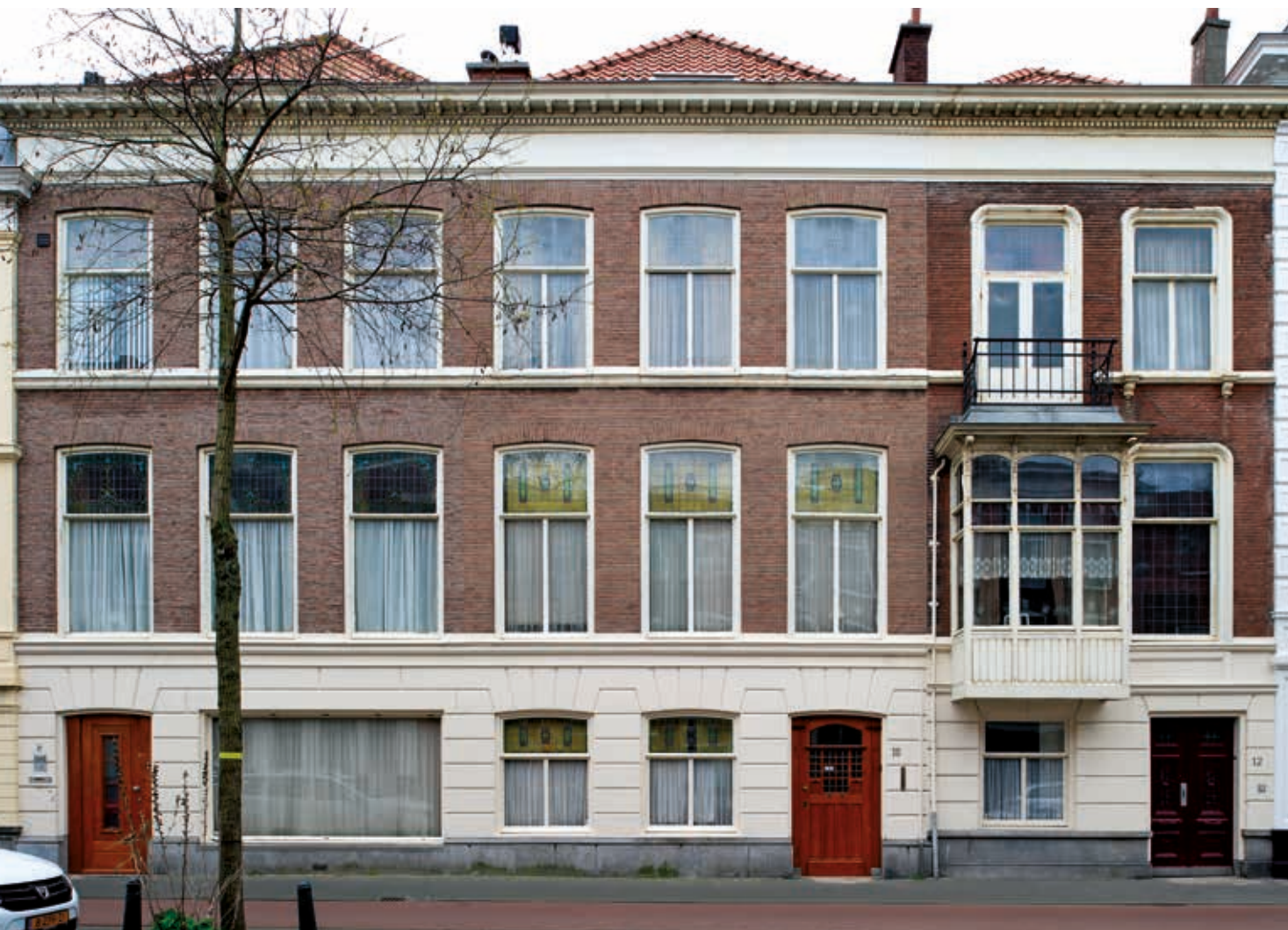
22. 'Burgermanshuizen' aan de Elandstraat in Den Haag. Elandstraat 12 (rechts) krijgt bij de huidige restauratie de historische kleurstelling van de gevel terug, foto Arjan Bronkhorst (Vereniging Hendrick de Keyser)
