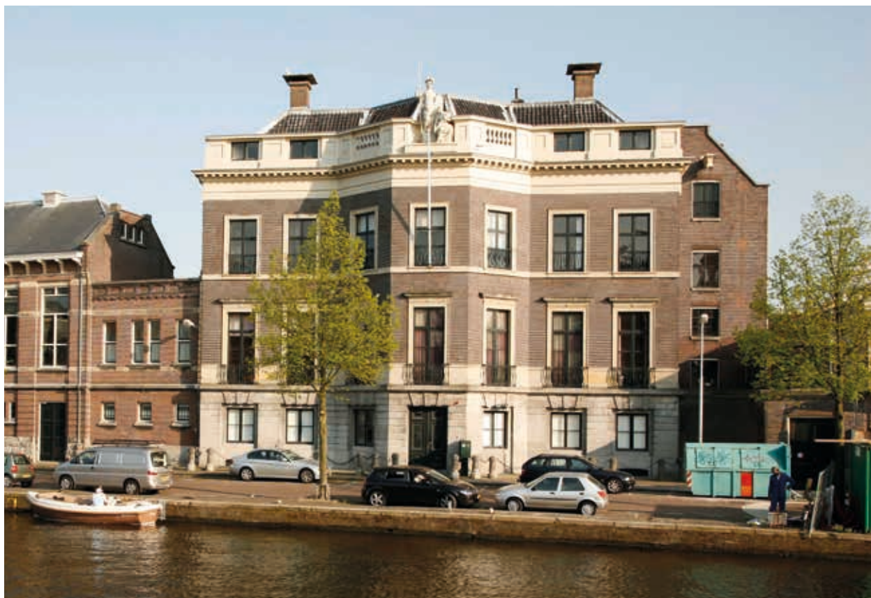
10. Huis Hodshon aan het Spaarne in Haarlem, verworven in 2008. De later aangebouwde 'aula' aan de linkerzijde kreeg bij restauratie haar oorspronkelijke kleurstelling terug (Vereniging Hendrick de Keyser)
