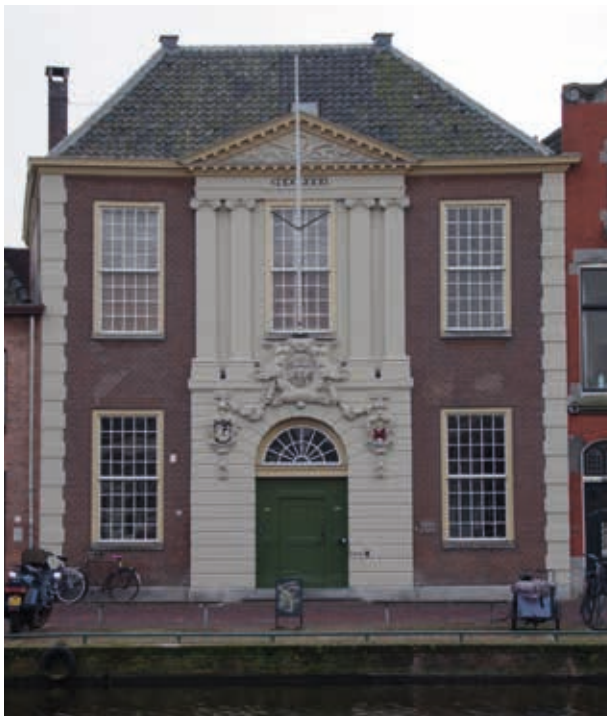
14. Voorgevel van het Hofje Meermansburg in Leiden uit 1681 (foto R. Stenvert, 2015).
