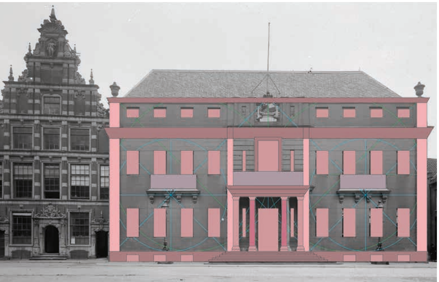
22. Voorgevel van het stadhuis (foto 1922) met ingetekende verhoudingen. De hoofdvorm wordt bepaald door twee cirkels van 45 Deventer Voet, resulterend in een middenrisaliet van 24 voet en twee vleugels van elk 33 voet. De roze onderdelen komen overeen met de maten in het bestek (Rijksdienst voor het Cultureel Erfgoed, bewerking R. Stenvert)
