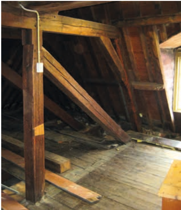
19. Deel van de kapconstructie van het poortgebouw van het Hofje Meermansburg. Het spant is voorzien van een verticaal geplaatste stijl die aan de rechterzijde is afgeschoord (de schoor aan de linkerzijde is later verwijderd) (foto P.J. De Vos, 2014)
