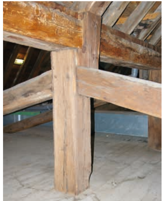
26. Detail van de aan twee zijden afgeschoorde korte stijl in het midden van de constructie die de zakgoot draagt (foto R. Stenvert, 2009)
