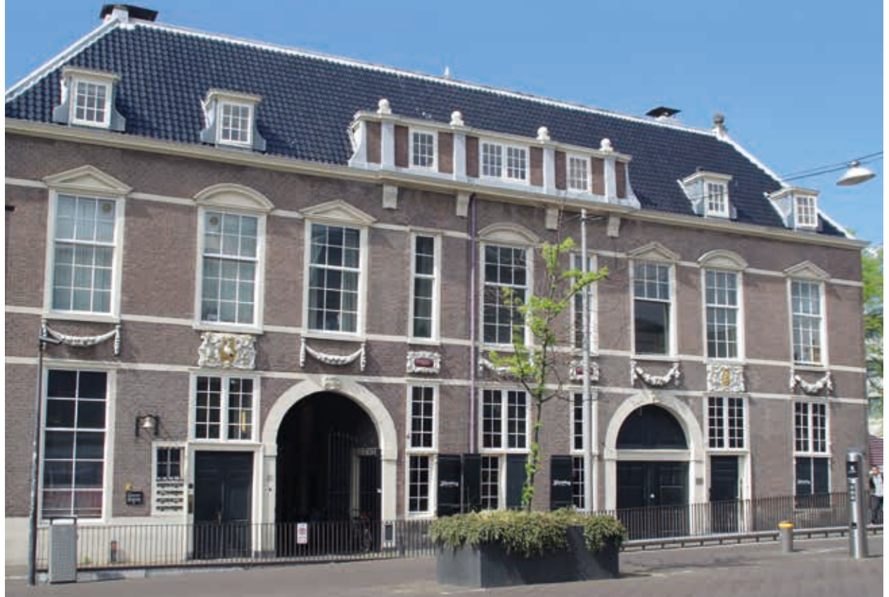
2. Het Groot Boterhuis in Den Haag uit 1650 werd in 1681 door Roman verbouwd. Met name de gedeeltelijke attiek boven de daklijst is een bij Roman veelvoorkomend element (foto R. Stenvert, 2017)
