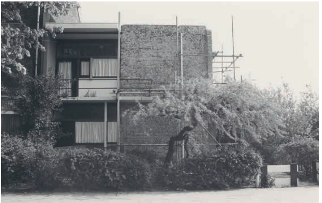
6. Het kale metselwerk van de muur aan de Prins Hendriklaan in 1979. Op de borstwering onder het raam van het voormalige atelier van Rietveld (linksonder) is nog stucwerk zichtbaar (Bertus Mulder archief)
