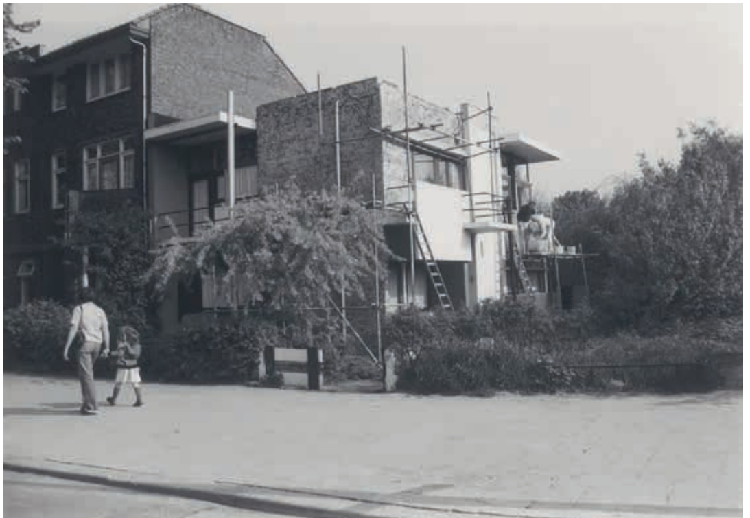
5. In 1979 staat het Rietveld Schröderhuis weer in de steigers nadat de problemen met het stucwerk zijn teruggekeerd. Grote delen van het stuc worden eerst afgebikt, waarna een nieuwe laag wordt aangebracht (Bertus Mulder archief)
