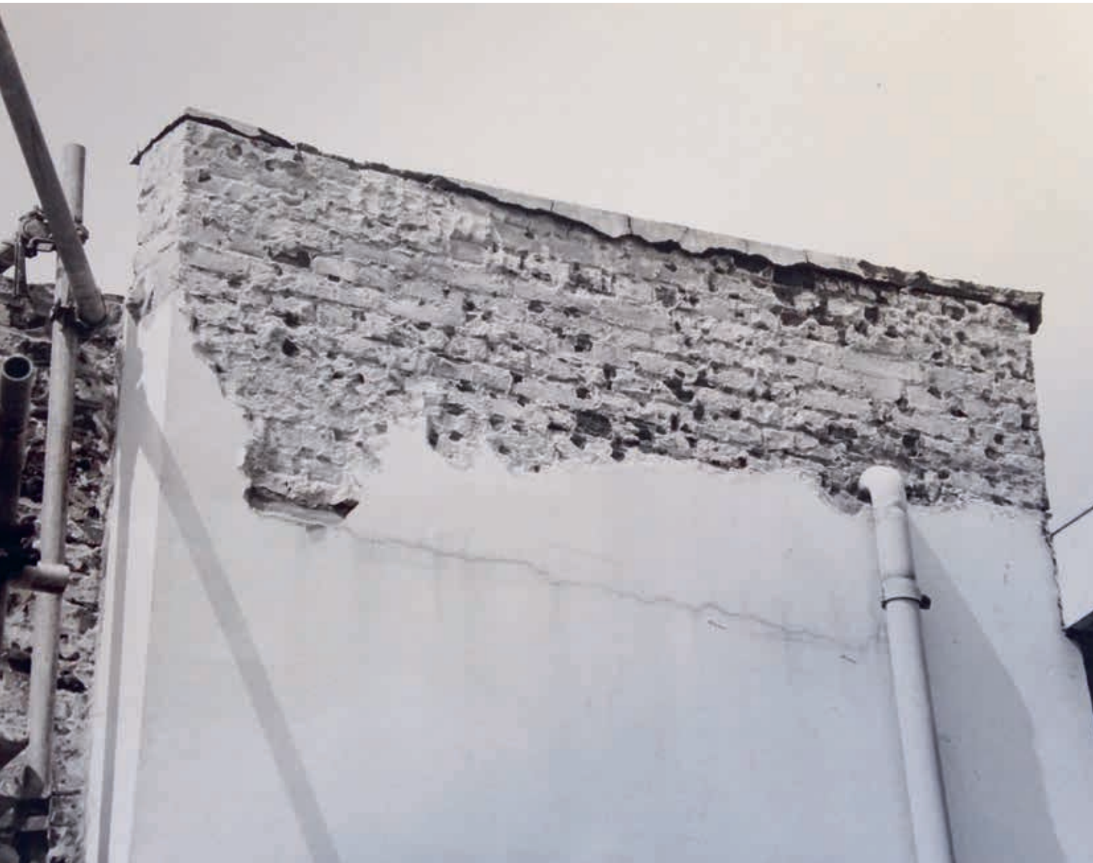
7. De witte wand rechts naast de voordeur van het Rietveld Schröderhuis wordt in 1979 alleen aan de bovenzijde afgebikt (Bertus Mulder archief)
