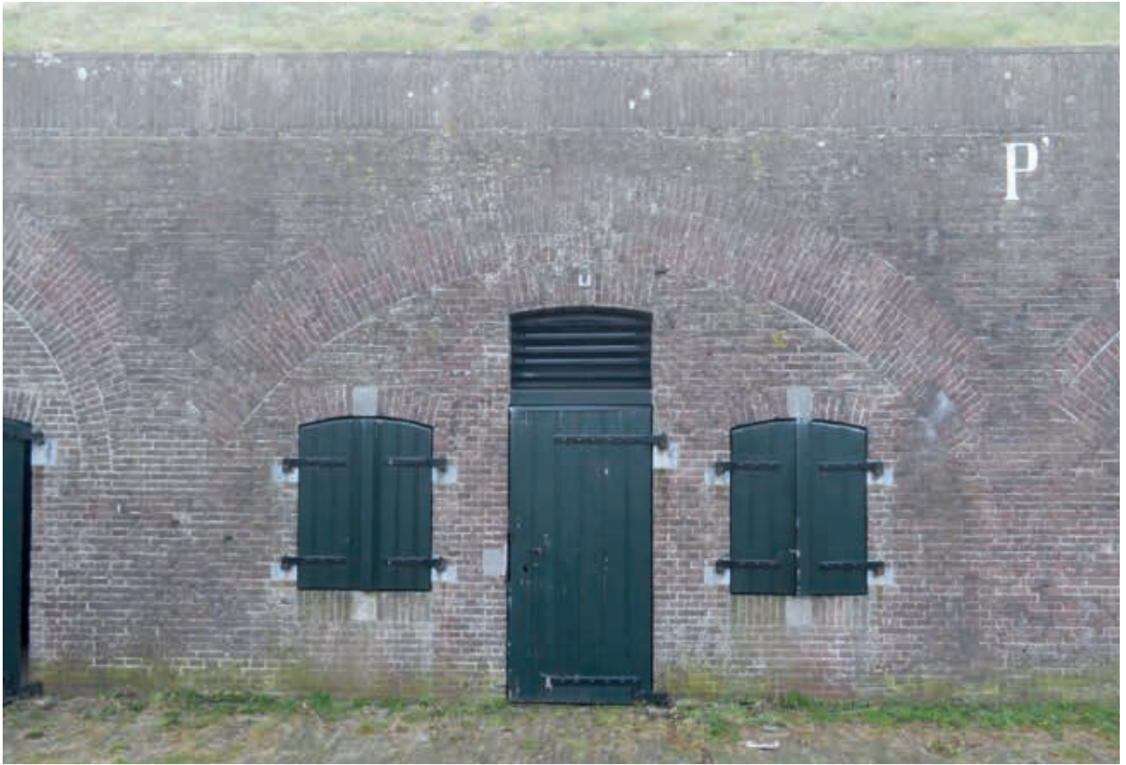
6. Oude kleursituatie van het buitenhoutwerk van de militaire gebouwen, gebouw P' op ravelijn 6 (J. van der Werf, maart 2018)
