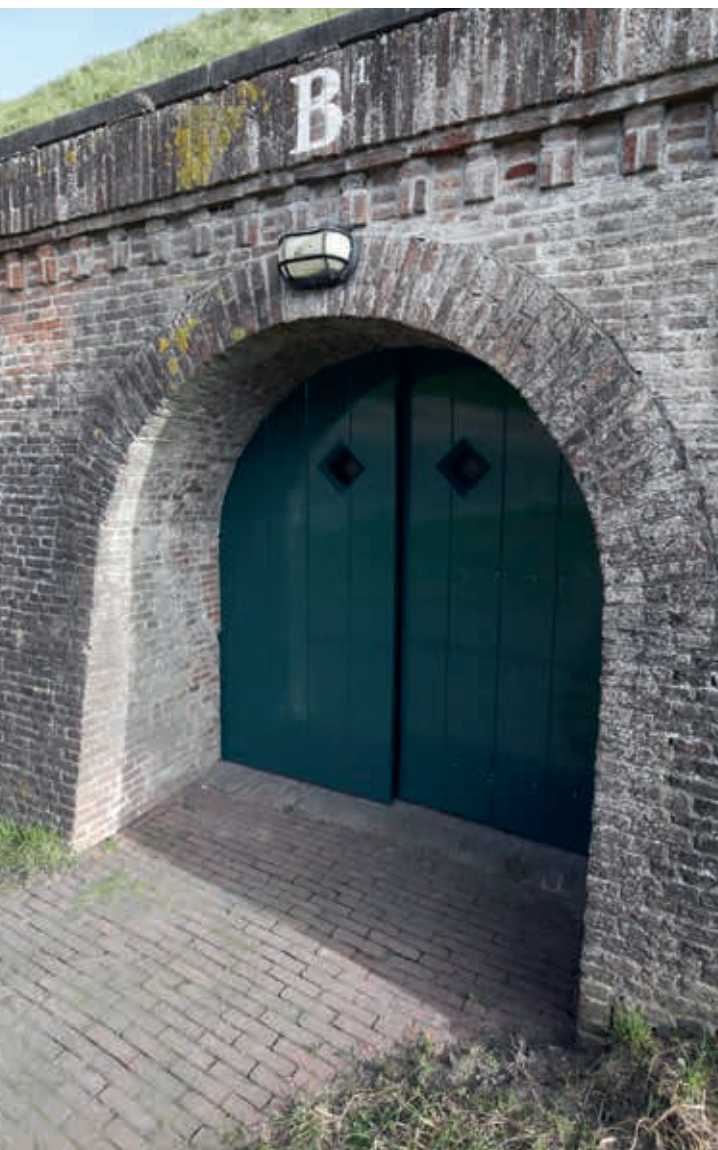
7. Nieuwe kleursituatie van het buitenhoutwerk van kazemat B' op bastion Nieuw Molen (SMB, 20 februari 2019)
