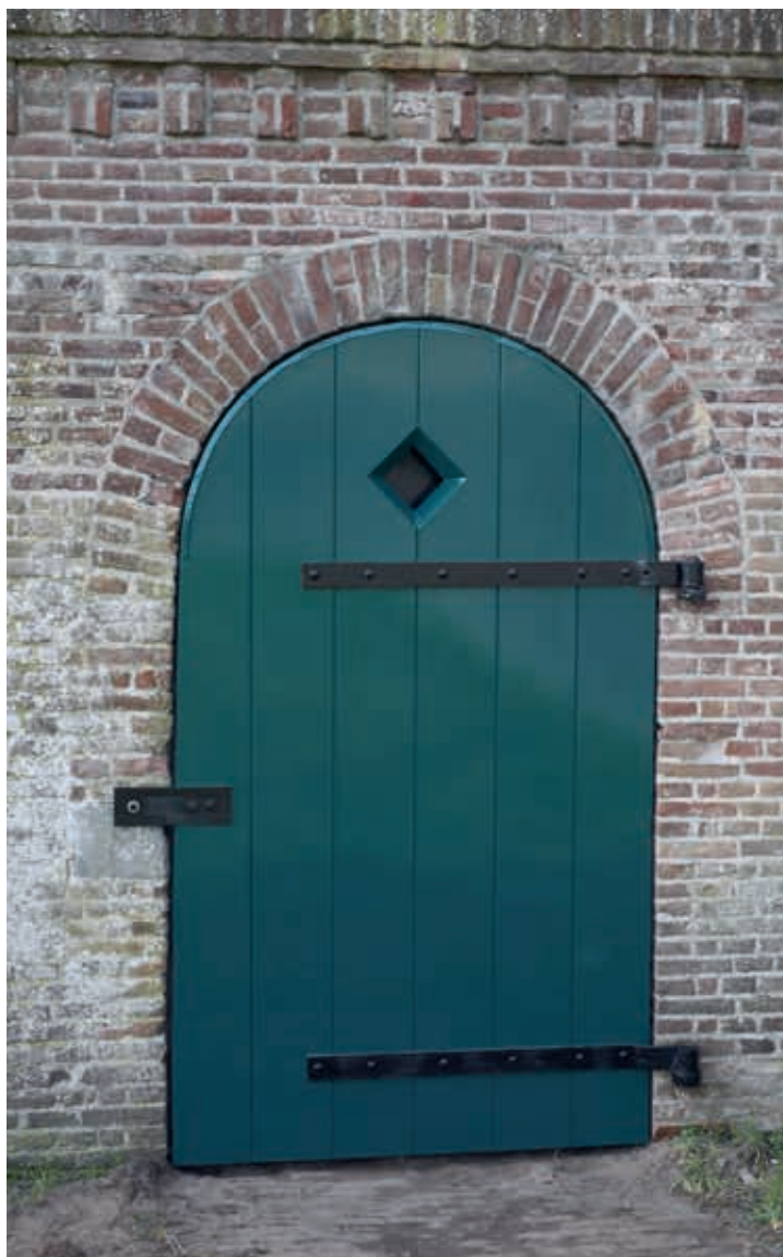
8. Kruitkamerdeur van kazemat c' op bastion Nieuw Molen (SMB, 20 februari 2019)
