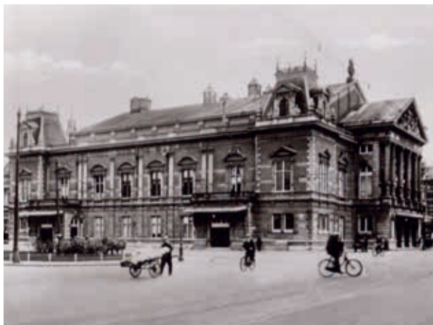
2. Het Concertgebouw rond 1900. Op het dak de ventilatietorens voor de afvoer van bedorven lucht uit de grote en kleine concertzaal (Stadsarchief Amsterdam)
