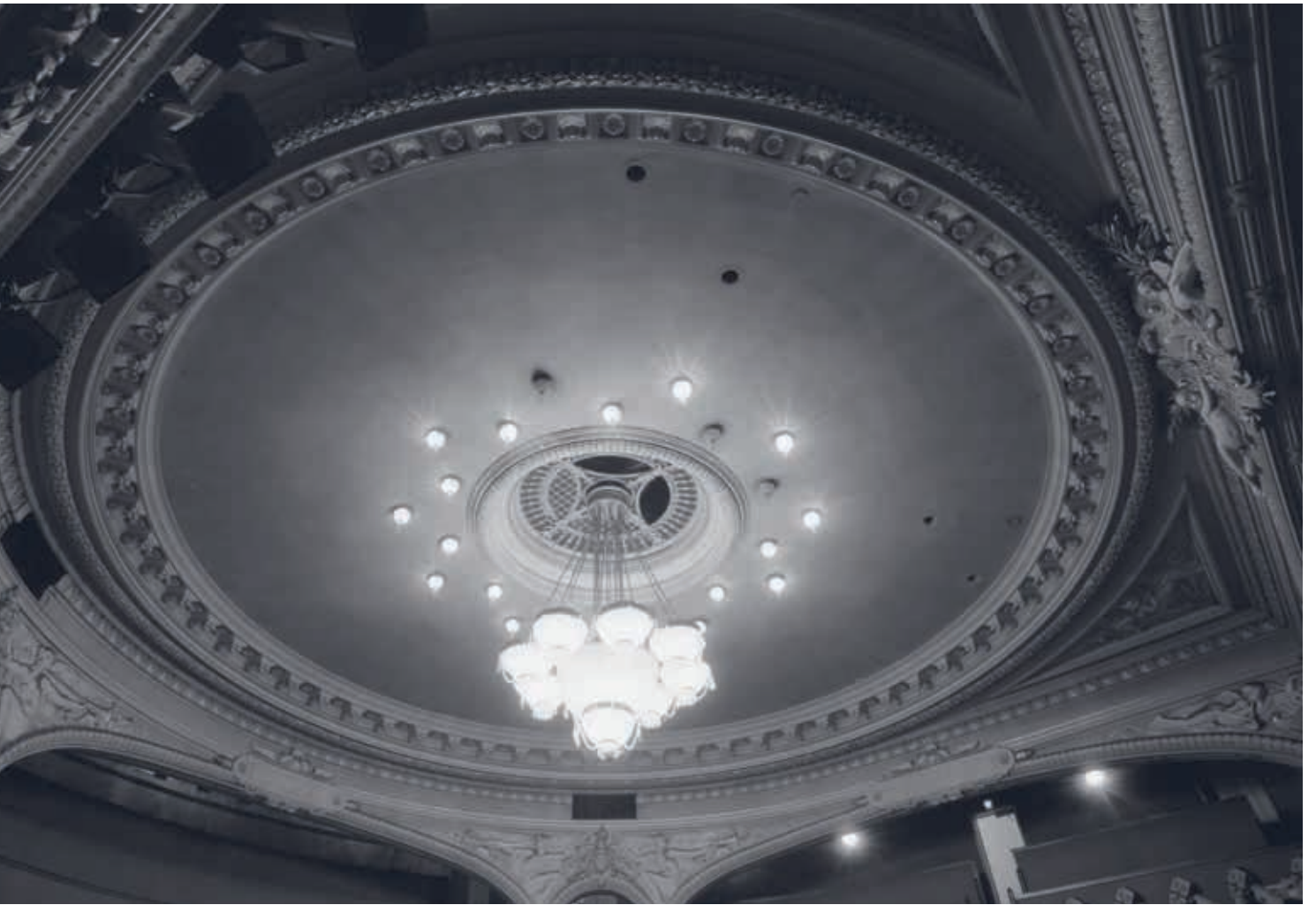
13. In de Stadsschouwburg aan het Leidseplein in Amsterdam was de ventilatie van de grote theaterzaal in de negentiende eeuw eveneens gekoppeld aan de toepassing van open gasverlichting. Ook hier bevond zich een grote gaskroon vlak onder de centrale afvoer voor bedorven lucht in het hart van het plafond. Door de warmte van de gaskroon ontstond extra trek, waarmee de lichtsnelheid van de afvoerlucht werd verhoogd (Stadsarchief Amsterdam)
