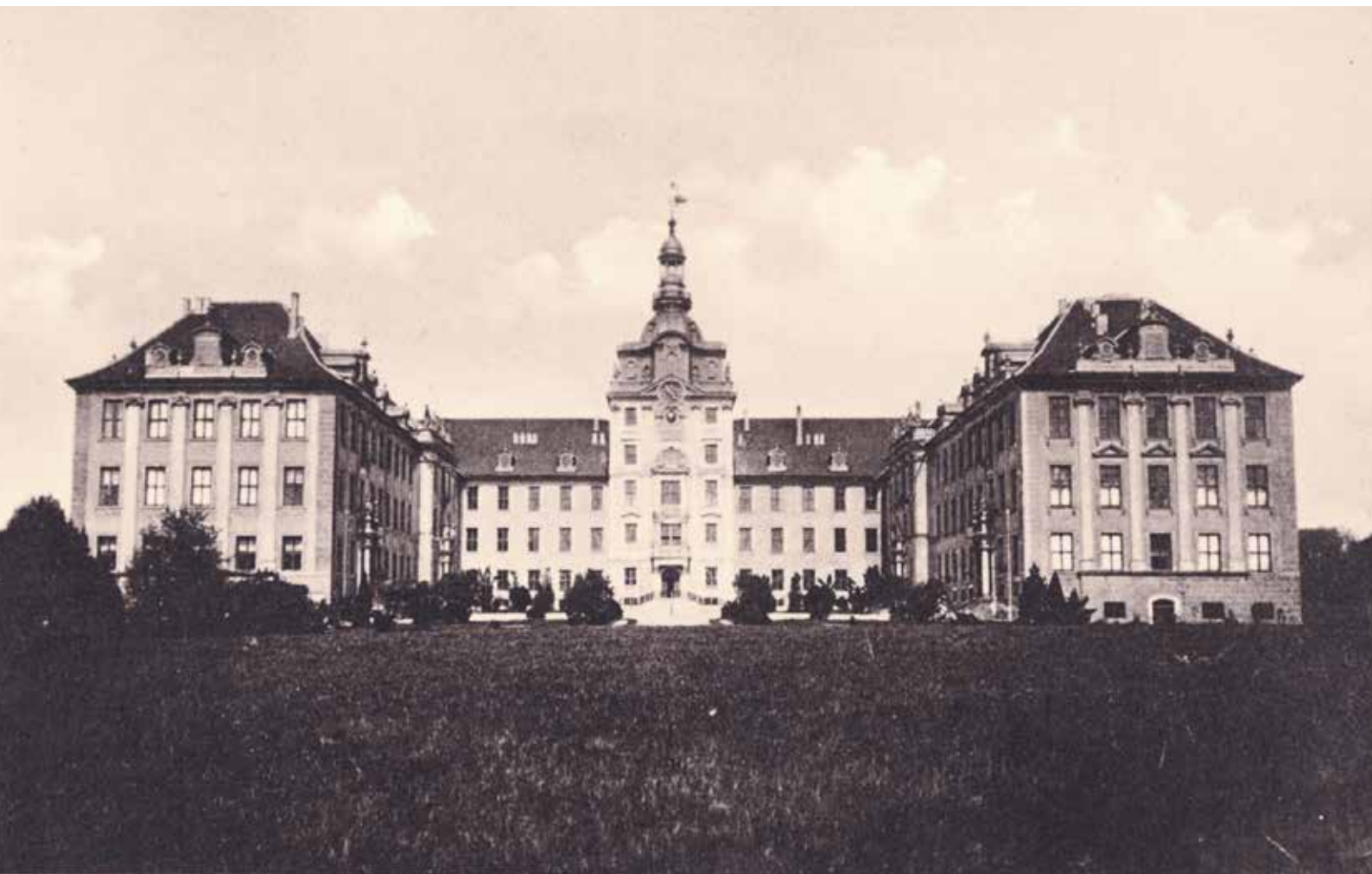
8. The castle in Zerbst, in a photo taken before 1940 (Technische Universität Berlin)
