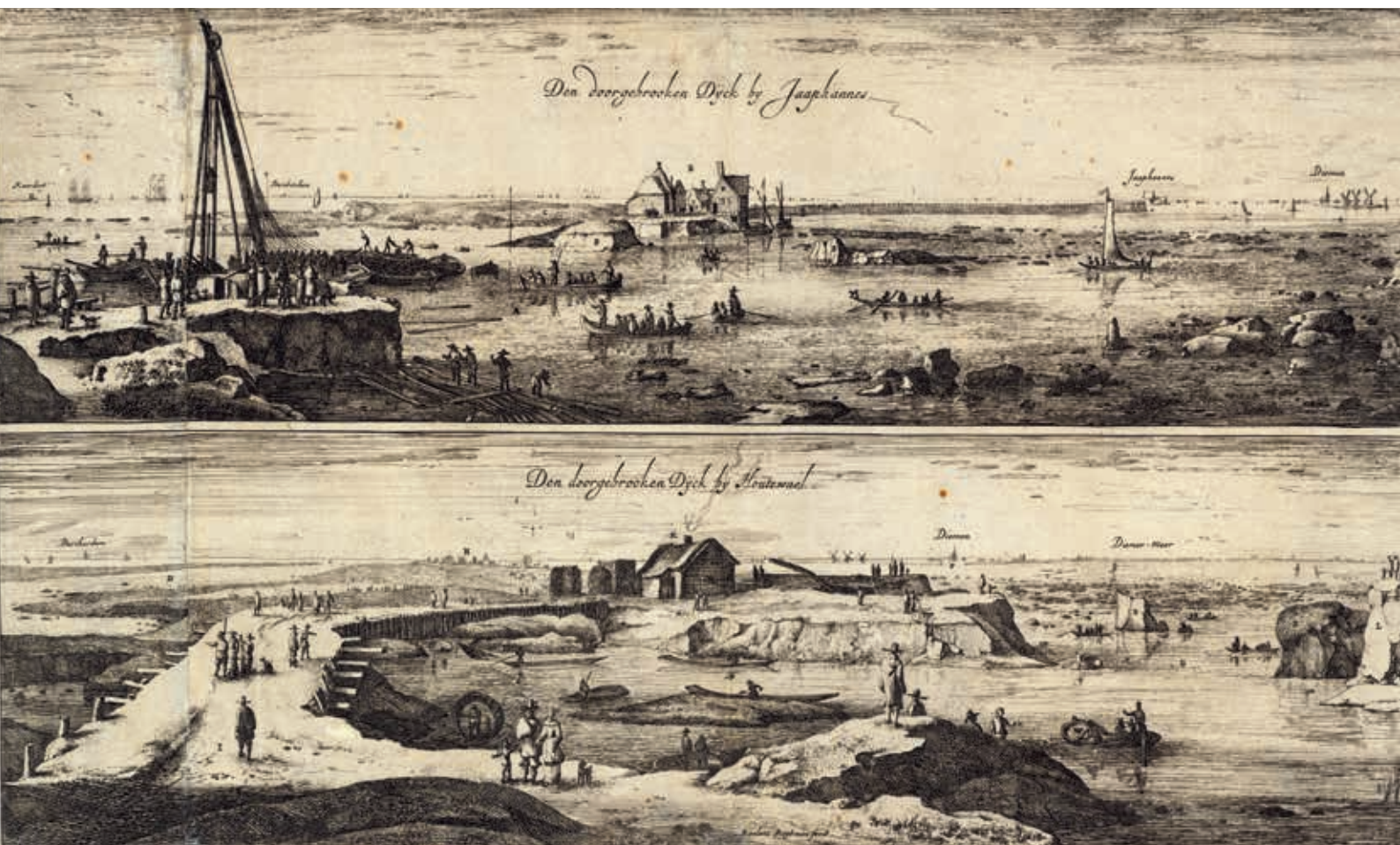
3. Roelant Roghman, Doorbraak van de Diemerdijk, 1651. Op de voorgrond van de bovenste afbeelding is een heistelling te zien, waarmee palen voor een nieuw deel van de dijk worden ingeheid. Op de onderste afbeelding is het dijkherstel al deels voltooid (Stadsarchief Amsterdam)
