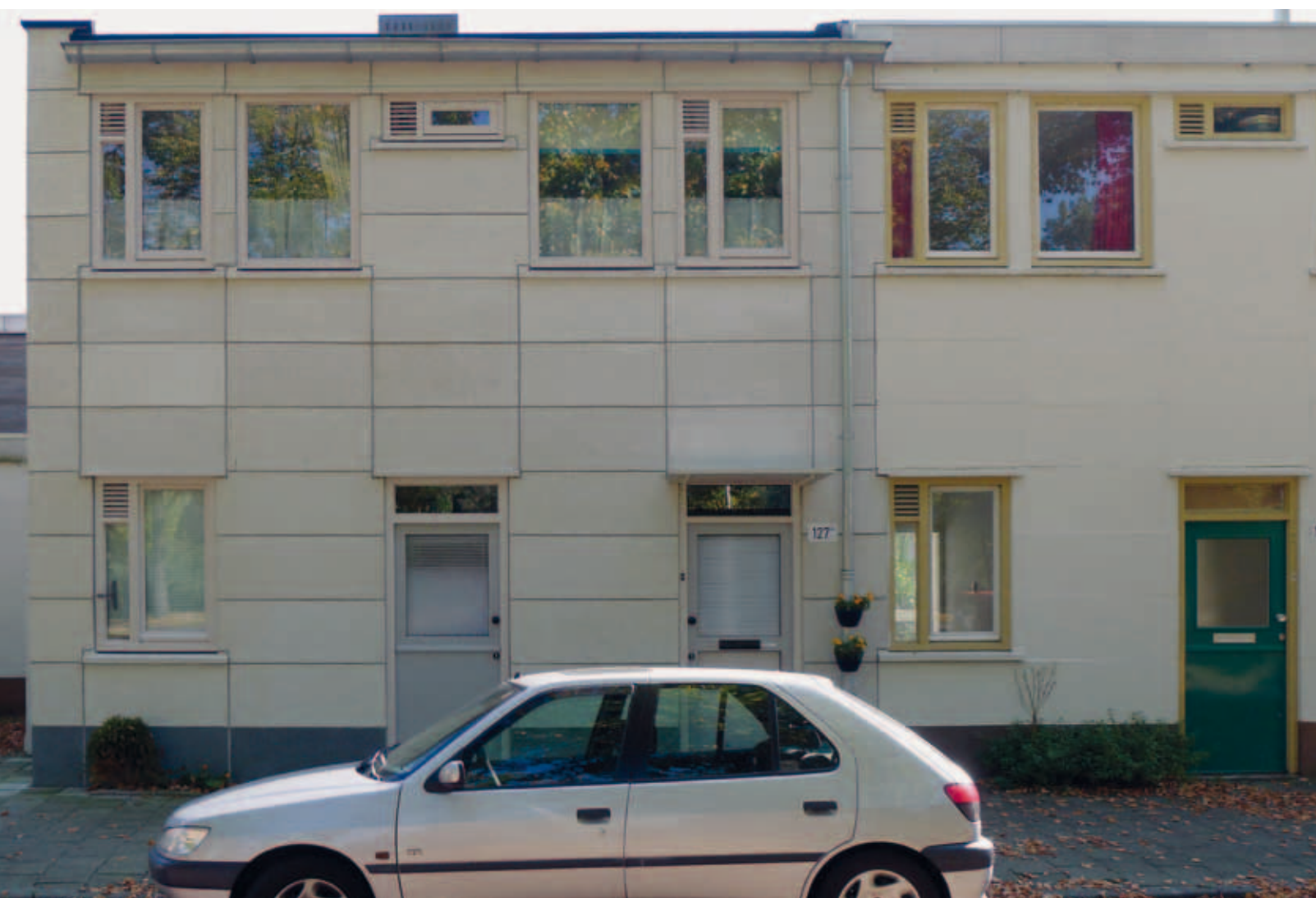
AFB.18. Voorgevel in 2011 na restauratie (foto Hielkje Zijlstra)
