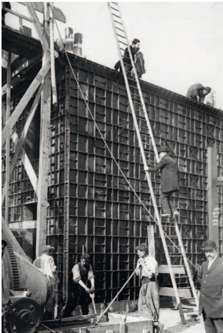
14. Huis in Saint-Denis tijdens de opbouw van de mallenconstructie (Étude d'histoire des techniques Seine-Saint-Denis Patrimoine béton, Pantin 2005, 22)
