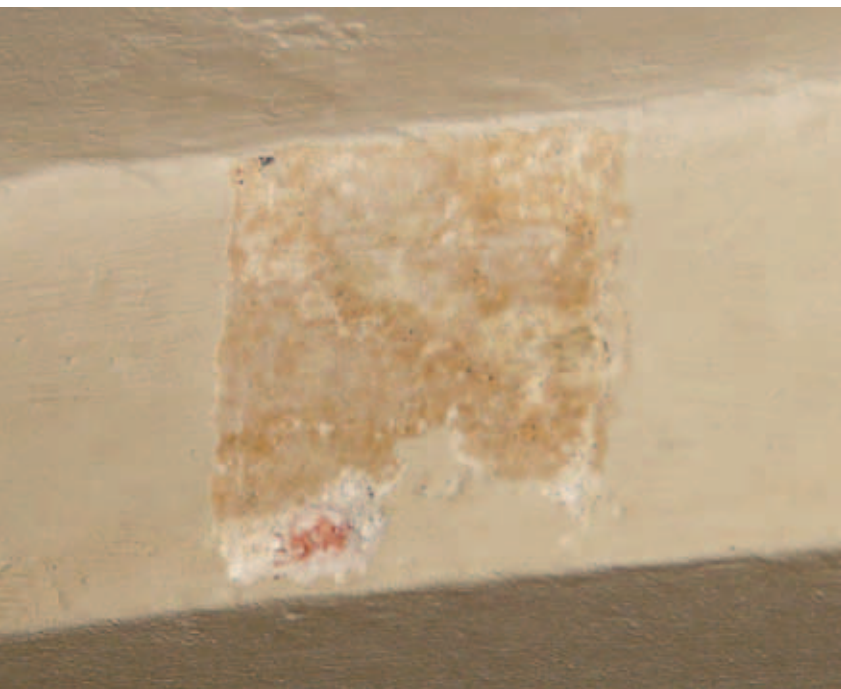
5. Vrijgekrabd vlakje op de zijkant van een plafondlijst van het gewelf van de Mozeszaal, waarbij het oorspronkelijke zandsteenkleurige pleisterwerk onder de huidige witte afwerking in het zicht is gebracht. Het rode 'vlekje' aan de onderzijde van het vlakje betreft het onderliggende baksteenwerk waarmee het gewelf is opgetrokken (foto Hein Hundertmark, 2008)
