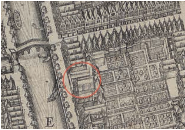
11. Uitsnede uit de kaart van Balthazar Florisz van Berckenrode uit 1625 (noorden onder), waarop de beide loodsen te zien zijn op de locatie van Herengracht 70-72 (Stadsarchief Amsterdam)
