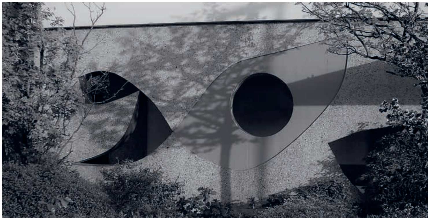
◀ 6. Flatgebouw aan de Bouriciusstraat in Arnhem (foto Renes, Gelders Archief, CC BY-SA 4.0)
