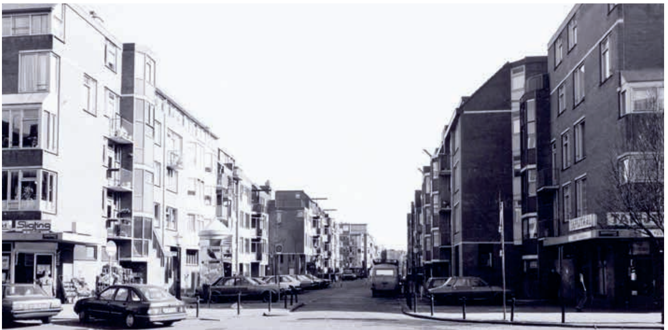
▼ 9. Zicht op de Wagenaarstraat vanaf de kruising met de Dapperstraat in de richting van de Pontanusstraat: rechts het eerste project, links op de hoek het vierde project, daarachter het tweede project en de tweede gevelsprong is onderdeel van het derde project, 1974-1982, maart 1985 (foto Martin Alberts, Stadsarchief Amsterdam)
