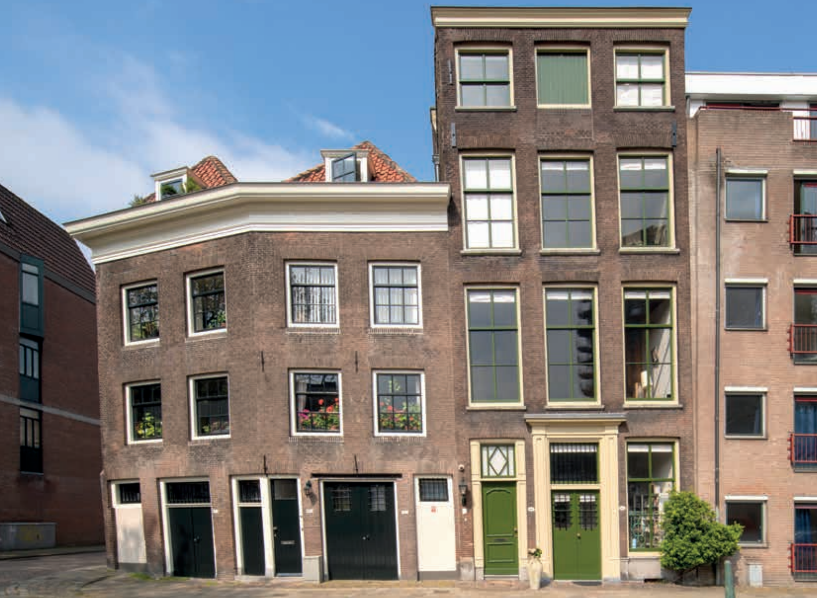
2. Het Koopmanshuis aan de Rechter Rottekade 405-407 (rechts) en het dubbelpand Rechter Rottekade 413-417 (links), Rotterdam, 2021 (foto R. Tilleman, Rijksdienst voor het Cultureel Erfgoed)
