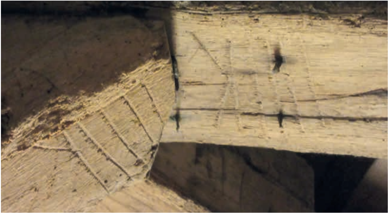
12. Detail van het eikenhouten tafelment in de noordwestelijke toren van de Grote Zaal. Op de bovenzijde van het korbeel en de onderzijde van de balk van het bovenste horizontale raamwerk is het getrokken telmerk IIIIK aangebracht (foto H. Hundertmark, 2021)
