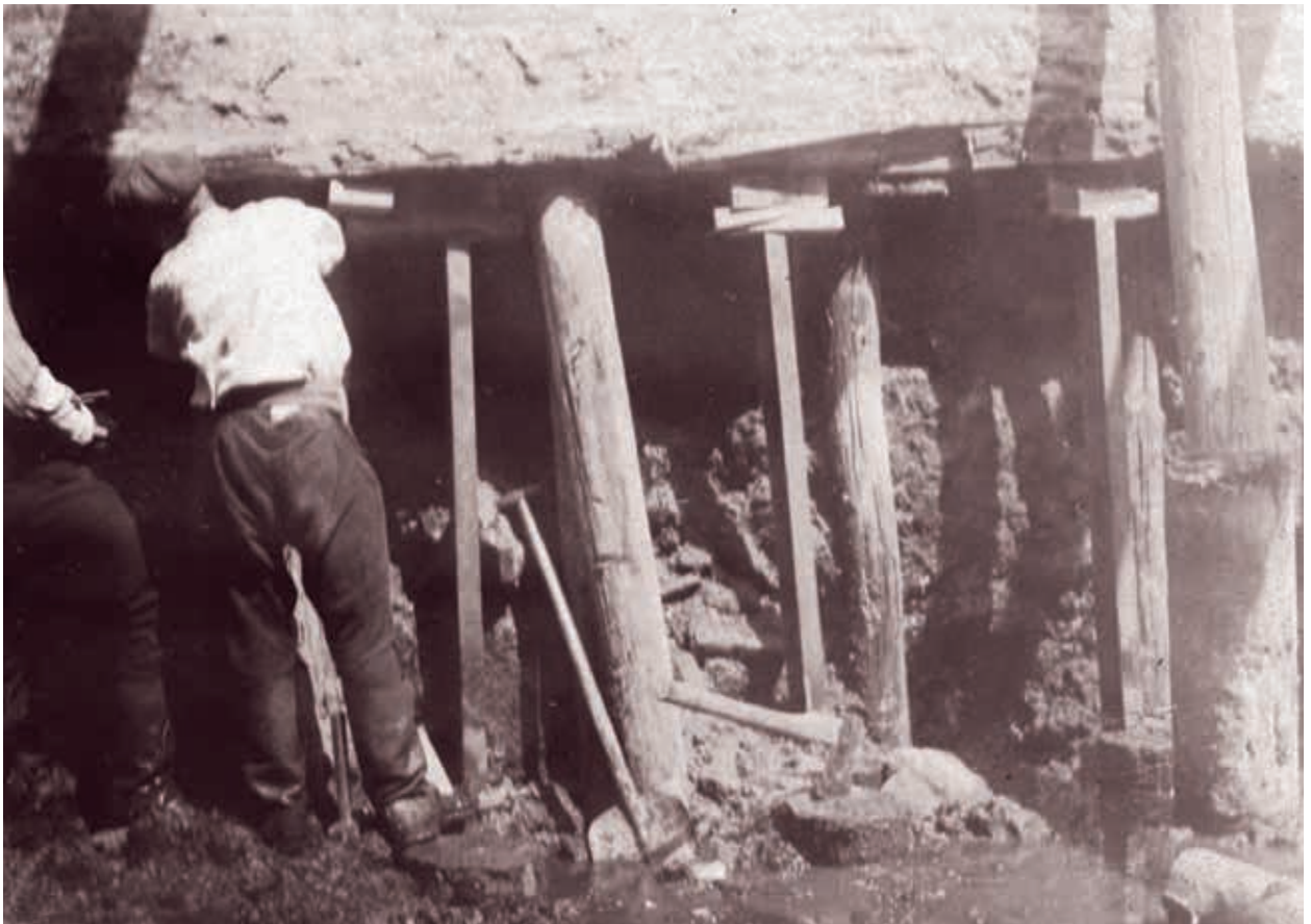
2. Amsterdam, Keizersgracht 313, funderingswerkzaamheden voor het gebouw van de firma Stokvis & Zonen, ca. 1914. De funderingspalen van het nieuwe gebouw zijn op de voorgrond te zien. De fundering van het deels op vijzels staande buurpand ligt aanzienlijk hoger (Stadsarchief Amsterdam)
