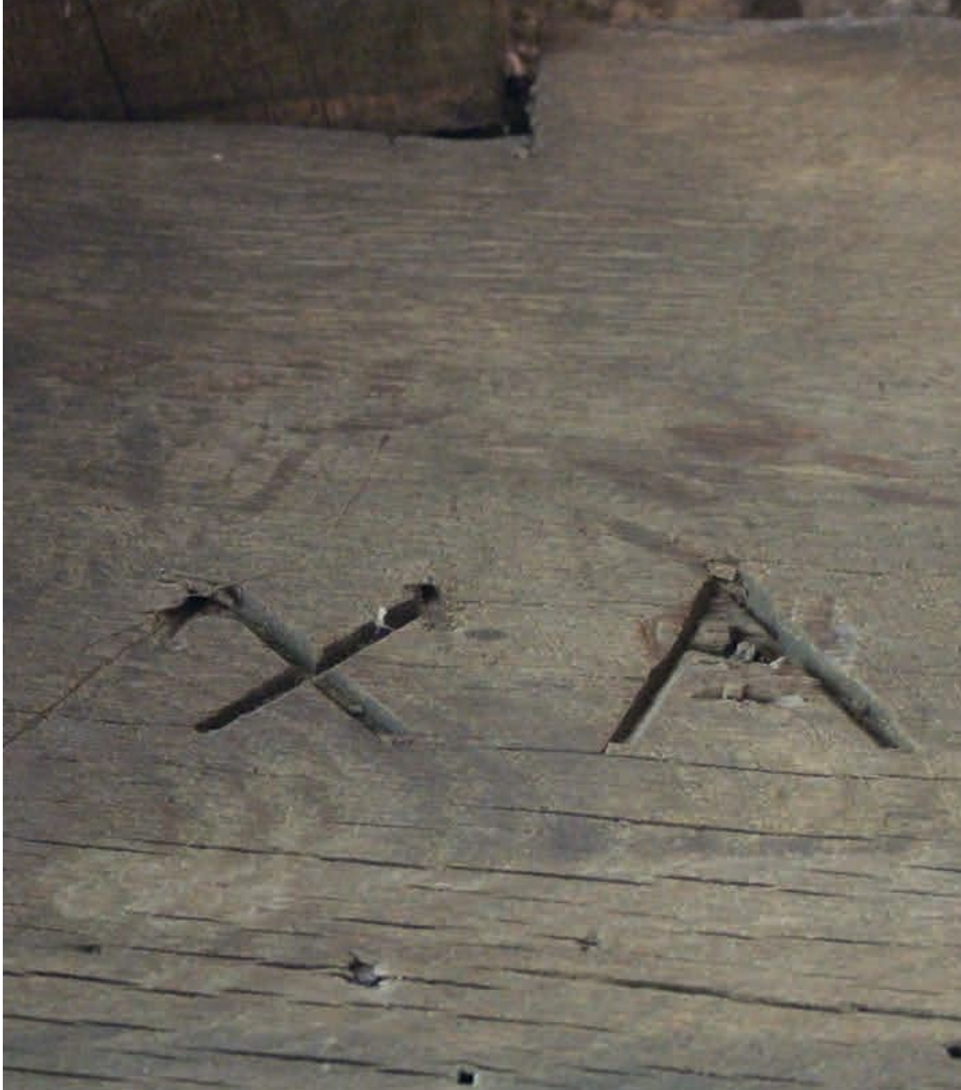
11. Schloss Reinbek bij Hamburg, ca. 1575, gehakt telmerk 19 op de dekbalk van een onderste spant (foto auteur)
