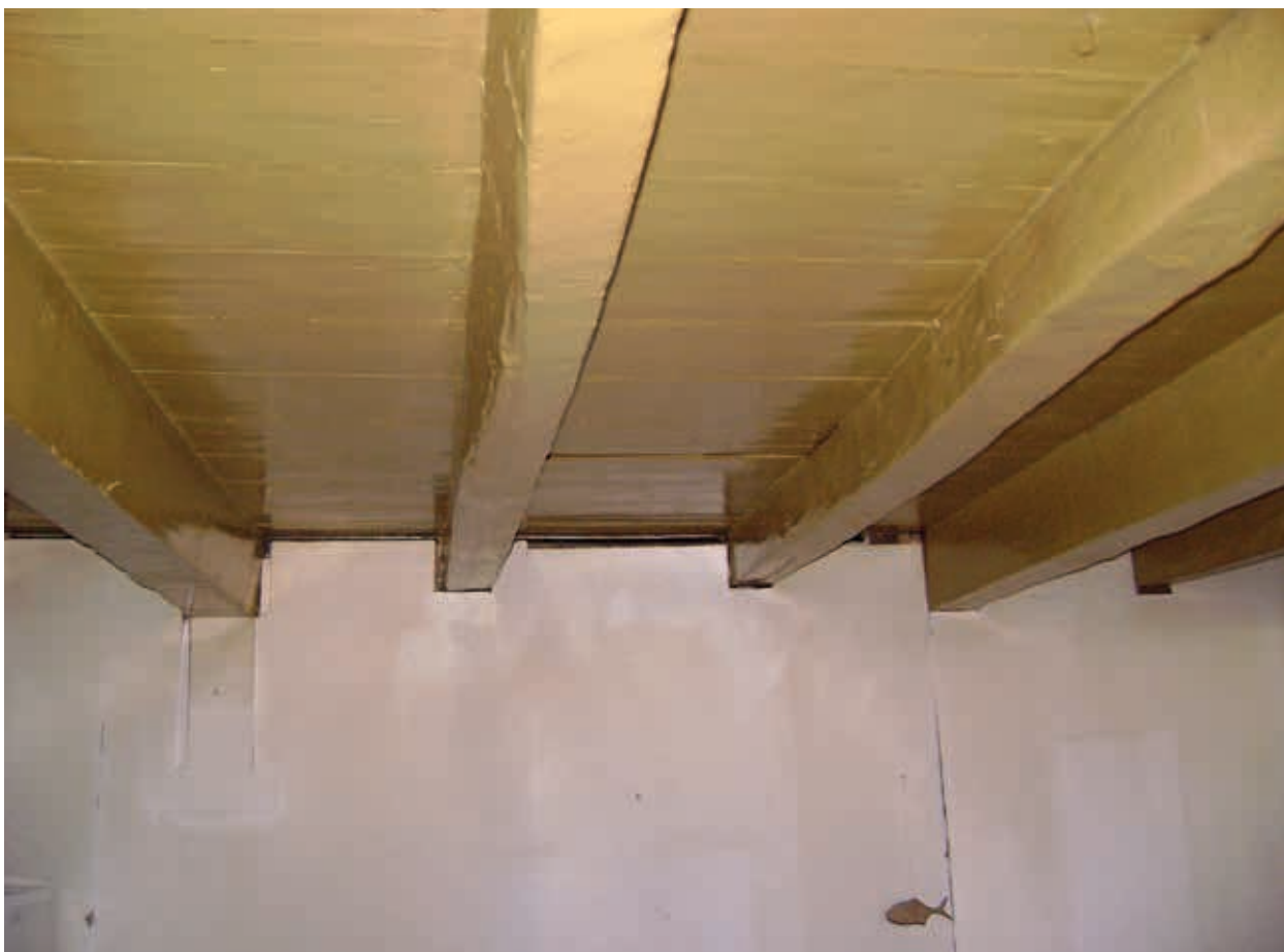
4. Balklaag eerste verdieping Oude Delft 68 in Delft (1544 d). Onder de zwaardere moerbalken stonden in de zuidelijke zijgevel korbeelstellen; de tussenbalken zijn oorspronkelijk. Op deze balken zijn in 2014 jachtscènes uit het begin van de zeventiende eeuw tevoorschijn gekomen (foto auteur)
