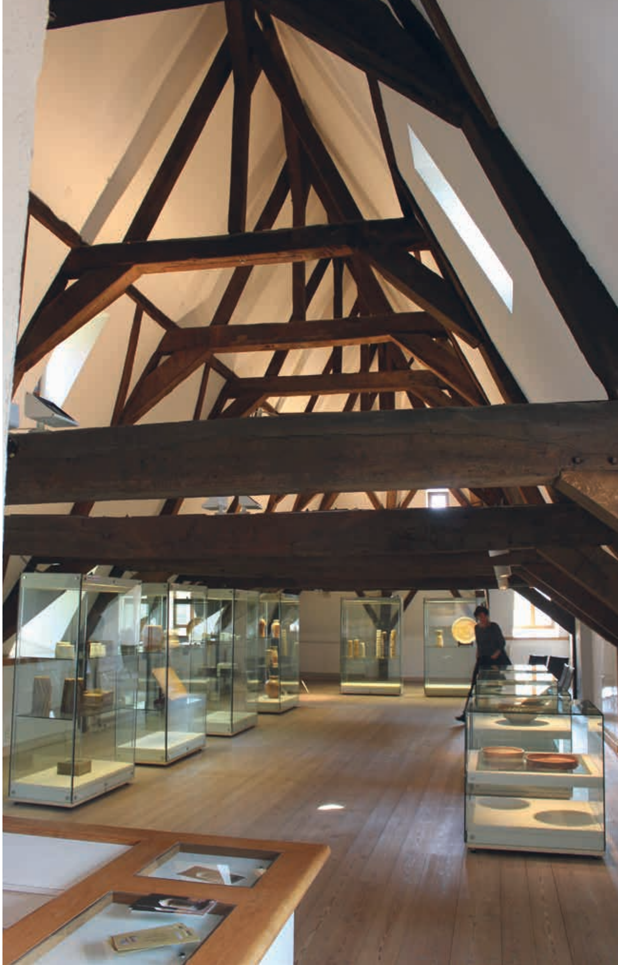
10. Schloss Reinbek bij Hamburg, ca. 1575, eiken kapconstructie met twee dwarse, gestapelde jukken en geschoorde nokgording (foto auteur)
