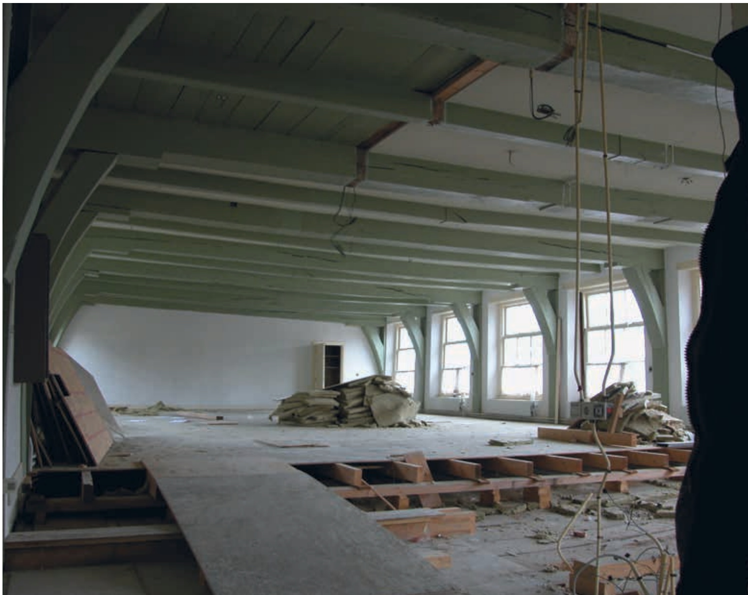
2. Zaal met korbeelstellen onder de moerbalken op de eerste verdieping van het Broederenklooster in Kampen. Onder de verhoogde, nieuwere vloer bevinden zich de oorspronkelijke grenen delen, waarschijnlijk uit 1481 (foto auteur)
