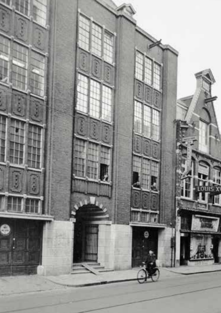
6. Gratama en Dinger, nieuwbouw archiefgebouw Incasso Bank aan de Reguliersdwarsstraat 90-92 in Amsterdam (Stadsarchief Amsterdam)
