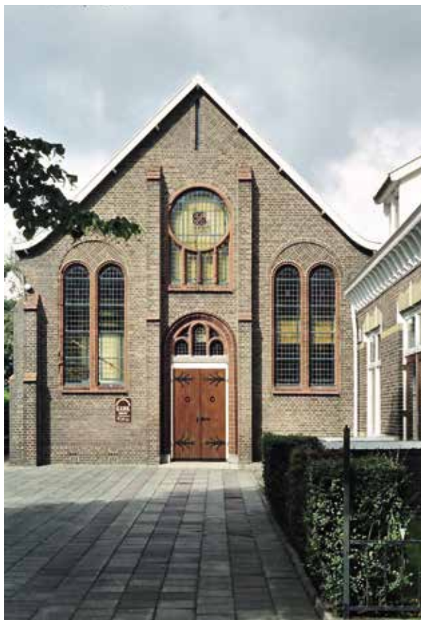
11. P.S. Dijkstra, Gereformeerde Kerk De Vlaswiek aan de Rijksweg in Hoogersmilde, gebouwd in 1916 (foto Hans1967, Reliwiki)
