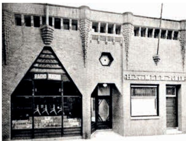
16. P.S. Dijkstra, shop and office of radio dealer H.J. van der Meer and Sons on Nieuwstraat in Vlissingen , built in 1923 and 1926 (photo J.L. van Leeuwen , 1978, Zeeuws Archief , Middelburg )
