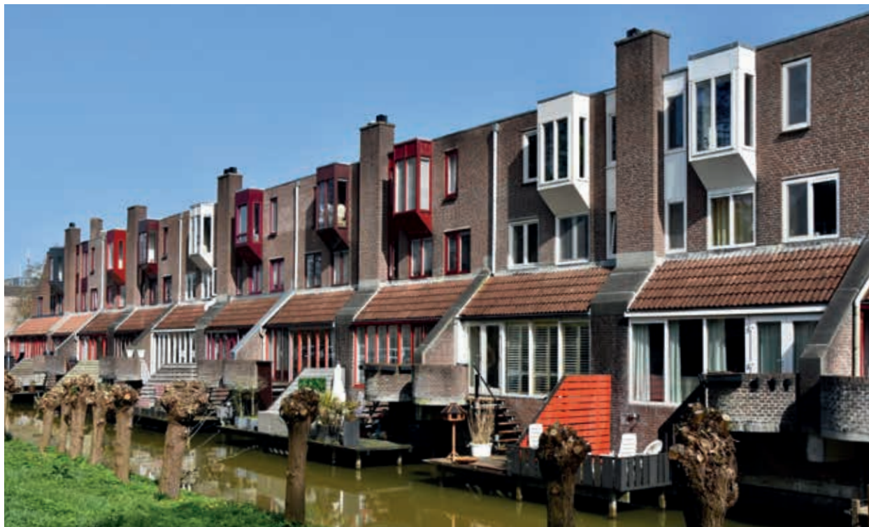
2. Pietro Hammel, waterwoningen in de Nieuwegeinse wijk Doorslag (foto Daphne Luijters)
