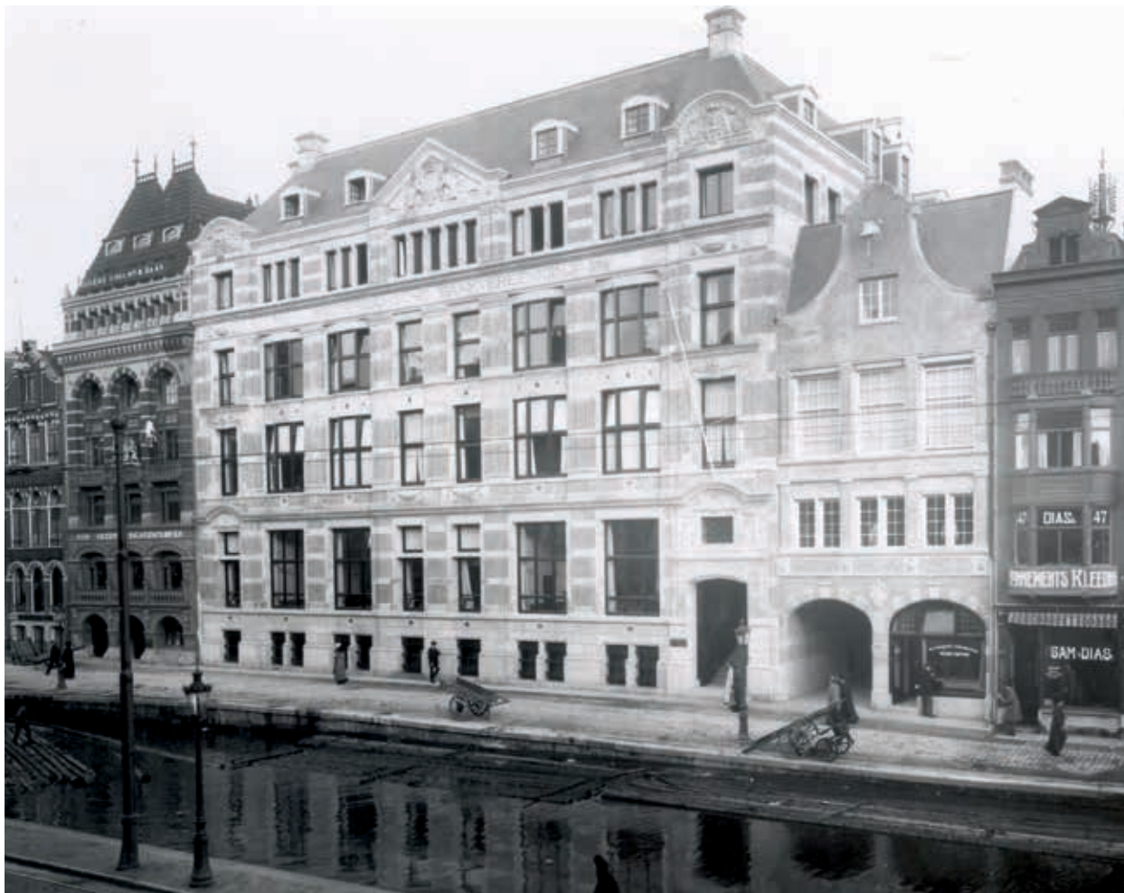
3. A.D.N. van Gendt, het in 1913 voltooide hoofdkantoor van de Rotterdamsche Bankvereening aan het Rokin (Historische Collectie ABN AMRO Bank)
