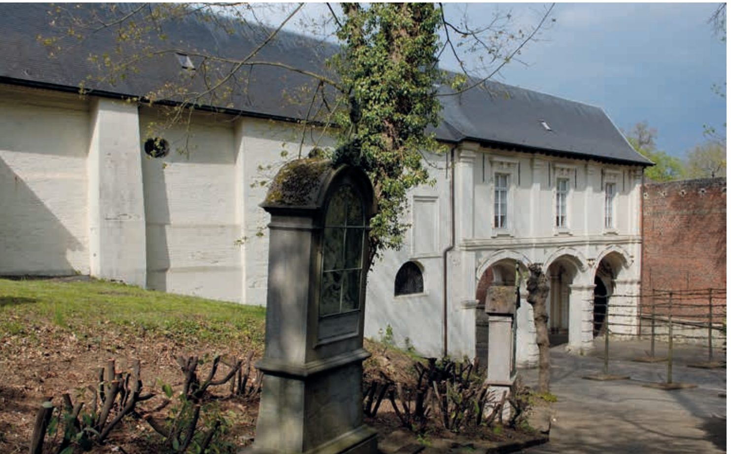
13. Exterieur van de galerij met rechts de passerelle die aansluit op de residentie van de oratorianen (foto auteurs)
