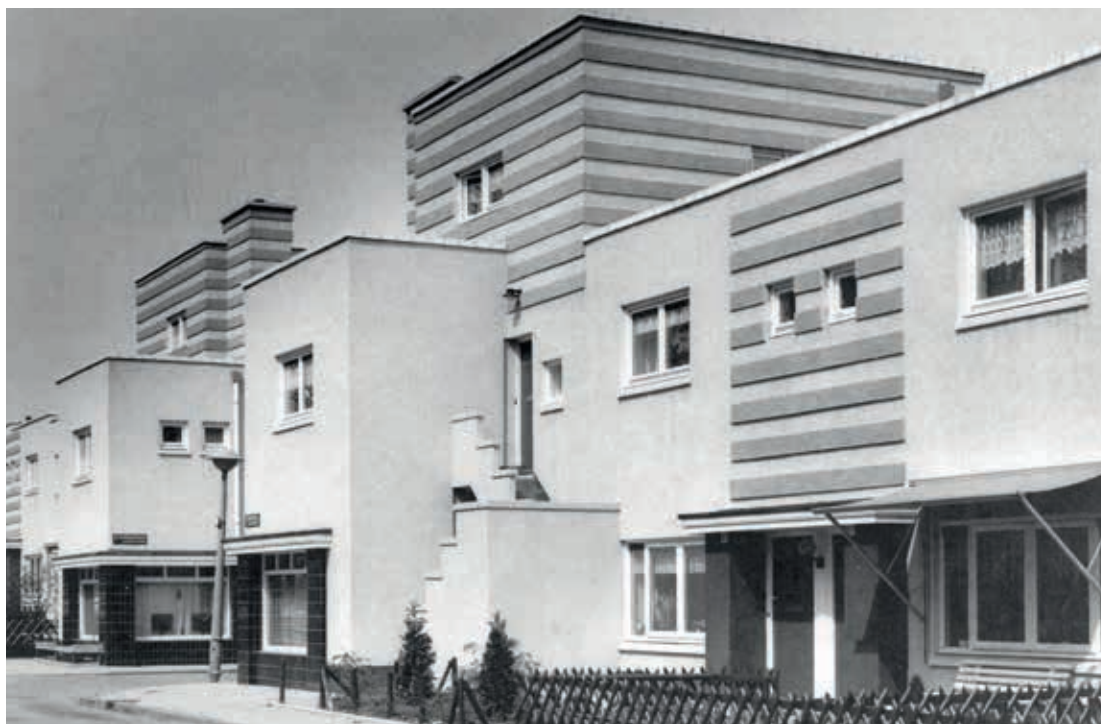
11. Winget-woningen in Betondorp in Amsterdam (na restauratie). (A. Bocanet, T. Boersma, L. Hermans, Betondorp 1923-1987. Gebouwd/verbouwd , Amsterdam 1987, 9)
