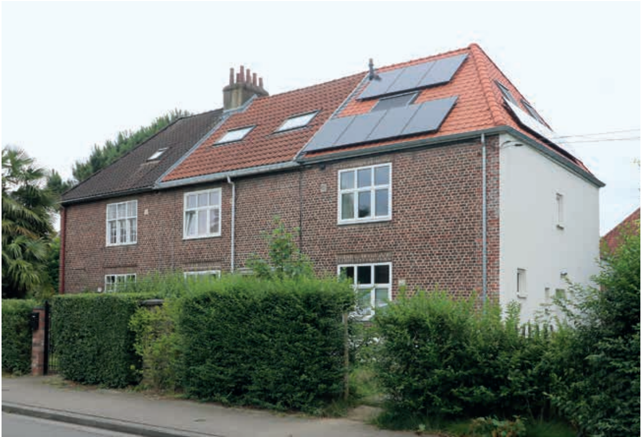
4. In het Rad werden, naast de experimentele bouwsystemen in beton, ook referentiewoningen in baksteen opgetrokken (foto Ine Wouters, 2024)
