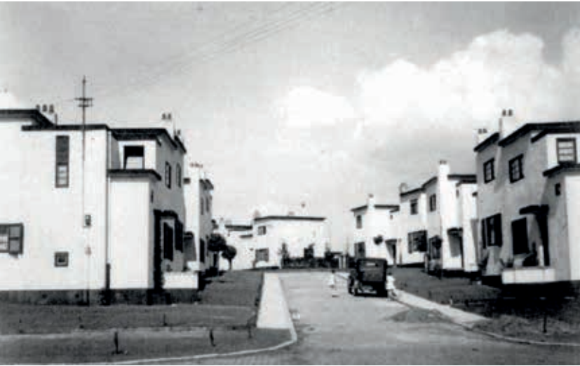
20. In Kapelleveld pasten Huib Hoste en Paul Rubbers het Belgische gietbouwsysteem Celtic toe, voor de constructie van respectievelijk 165 en 60 woningen (A. Verdonck e.a., Huib Hoste 1881-1957 , Antwerpen 2005, 132)
