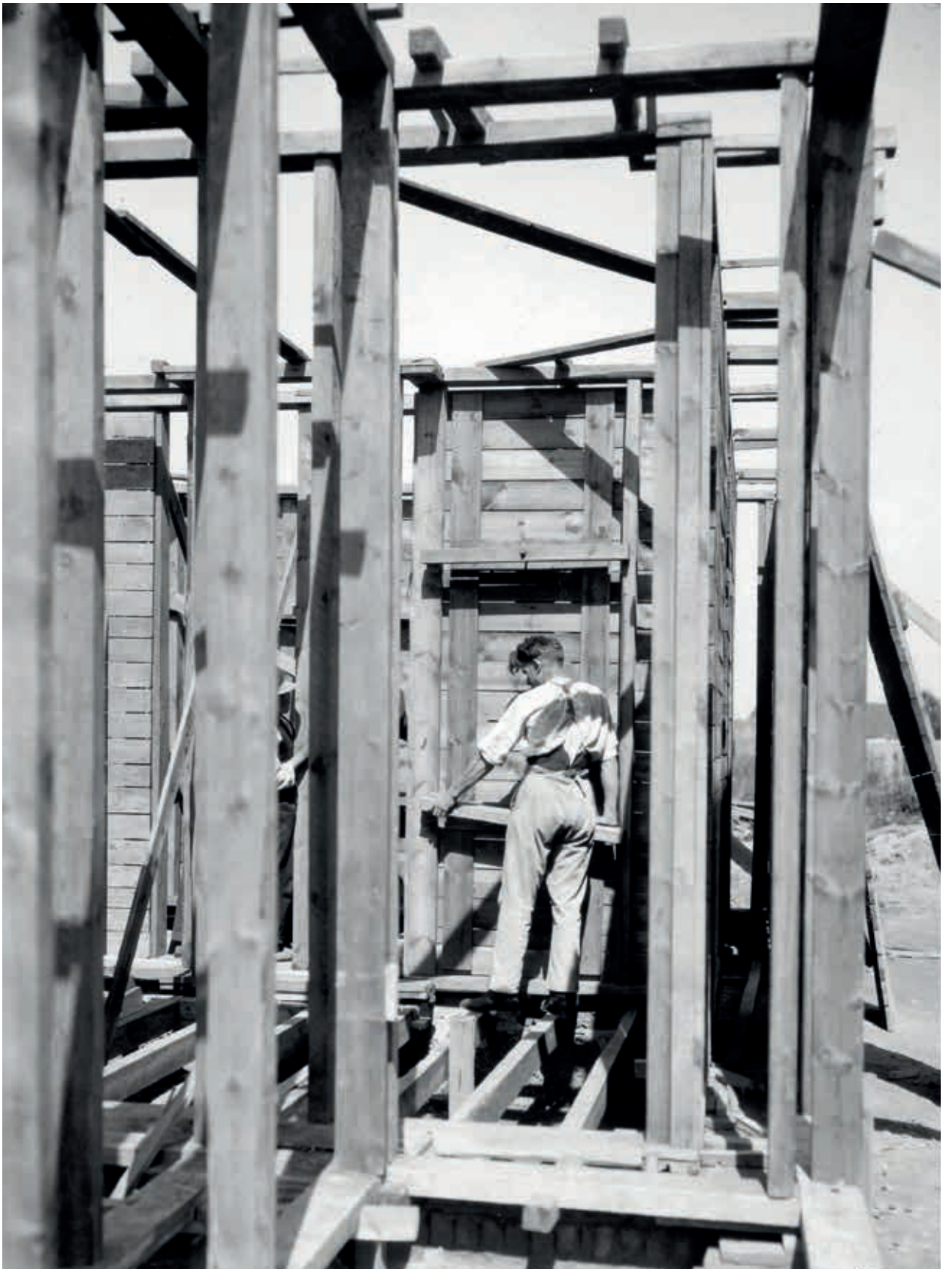
18. De constructie van de wanden van één verdieping met het Non Plus-systeem in La Cité Moderne nam, per twee woningen, twaalf dagen in beslag (CIVA Collections, Brussel)
