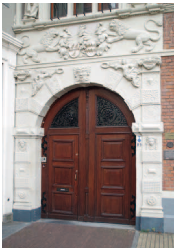
5. Poort van het Penninckshuis in Deventer, voorzien van Ionische pilasters en kapitelen met tussen de voluten een festoen, terug te voeren op het werk van Michelangelo (foto auteur)
