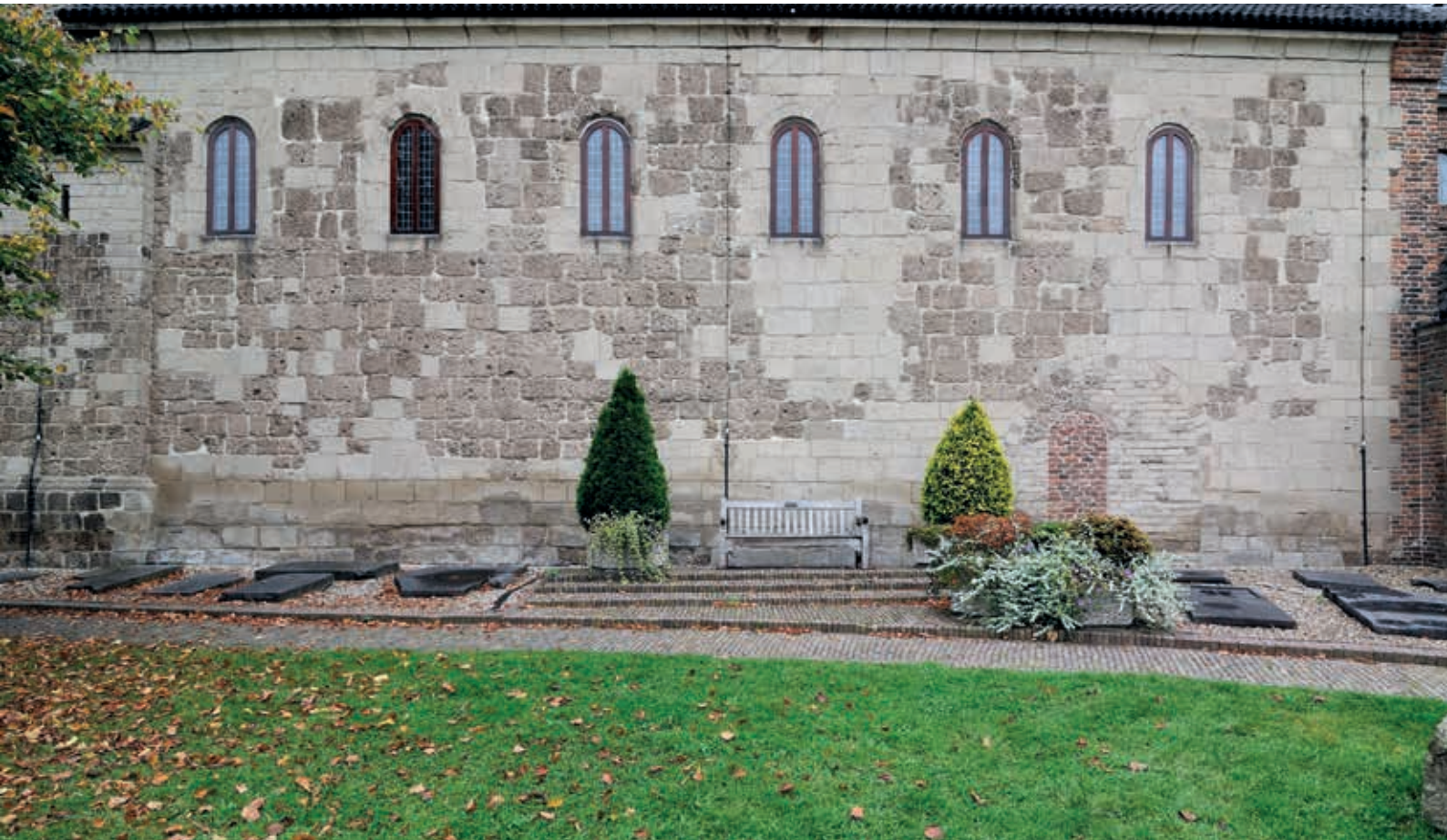
5. Oosterbeek, zuidmuur van de Nederlands Hervormde kerk, opgebouwd met uitzonderlijk grote, hergebruikte blokken (foto R.J. Stöver 2009, erfgoedfoto.nl)
