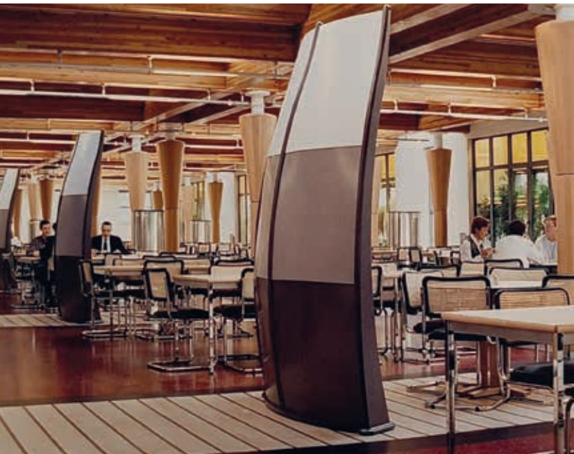
13. Interieur van het personeelsrestaurant voor de ruim vierduizend medewerkers van Dexia, ca. 2000. Frans Van Praet koos voor gelamineerde spanten, warme kleuren en indirect daglicht via daklichten en patio's. Verplaatsbare akoestische schermen en verwarmingselementen werden speciaal voor het restaurant ontworpen (Algemeen Rijksarchief, Brussel)
