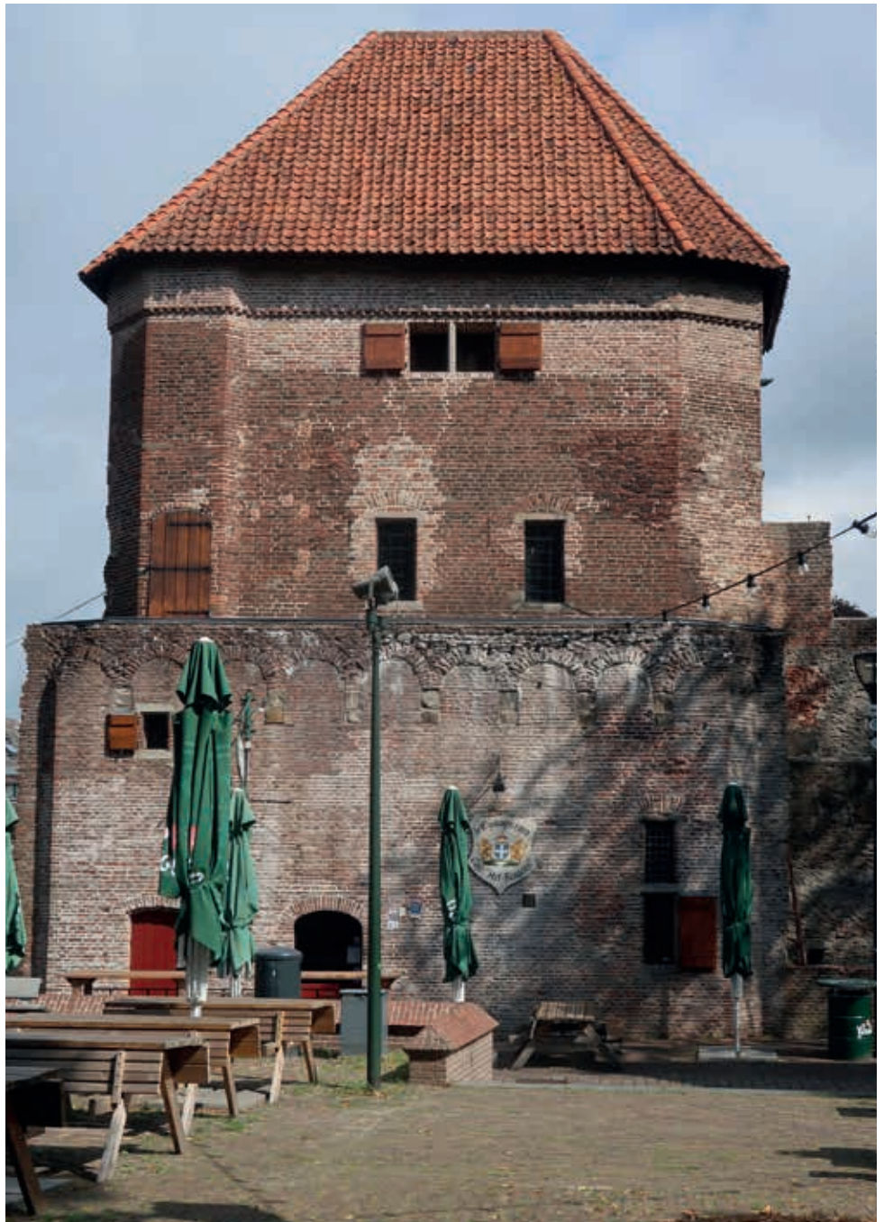
7. Waterstraat met de Wijndragerstoren, stadszijde, links de rode toegangsdeur van de traptoren, daar boven en de afgehakte arcade van de weergang. Het pannendak is later toegevoegd, situatie 2023 (Foto D.J. de Vries)
