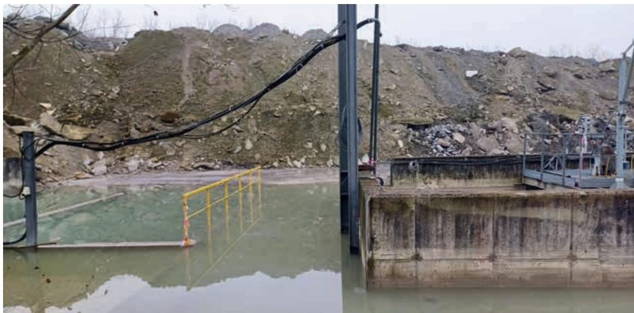
16. Grote restfracties cement en aggregaat gaan bij het spoelen van de mengmachine tussen verschillende mengingen in de betoncentrale in Sint-Pieters-Leeuw. Vandaag worden ze op voorschrift van milieuwetgeving gerecupereerd met behulp van bezinkingsbekkens. Wat voordien gebeurde met deze restfracties en met welke milieu-impact is niet geheel duidelijk. (Foto Tom Broes)
