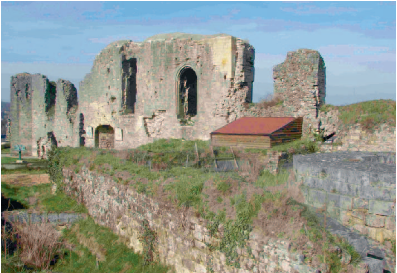
Afb. 13 De westwand van de Ridderzaalvleugel in 2006, bij de recente consolidatie is de vertanding van Sprenger (rechts boven) foutief vervangen door een rechte hoek (foto auteur)
