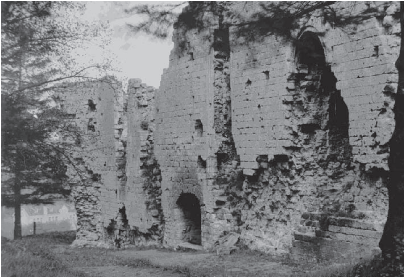
Afb. 9 De binnenpleinmuur van de Ridderzaalvleugel voor het begin van de ontgraving en consolidatie, ca 1920 (vergelijk met afb. 13, foto coll. RCE)
