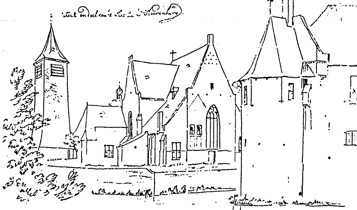
Afb. 5. Cornelis Pronk, 1731. Kerk en klokkentoren vanuit het westen gezien, rechts op de voorgrond nog een deel van het kasteel.
