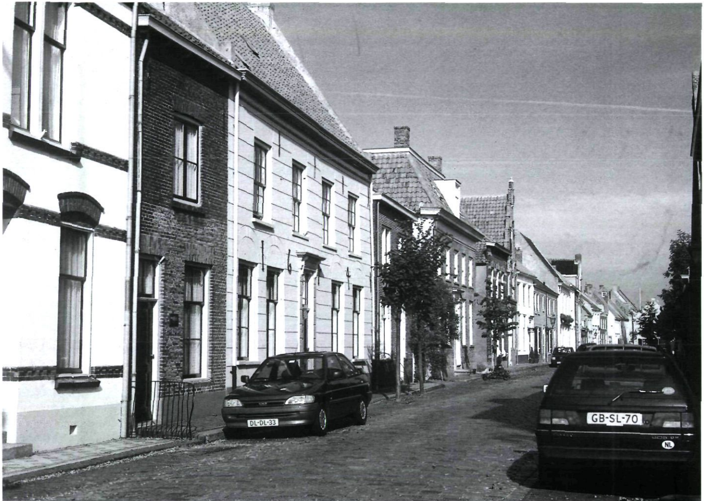
Afb. 1. Straatbeeld in de Rodeheldenstraat-Jodenkerkstraat te Buren, in noordwaartse richting (gesticht 1395, zie het artikel van Rutte in dit tijdschrift, waarin ook de plattegrond is afgebeeld). De gevelwanden meanderen licht, maar de straat is oorspronkelijk beslist recht bedoeld geweest.
