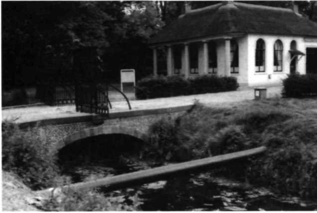
Afb. 5 Instandhouding in de praktijk leidt niet altijd tot gewenste resultaten, vooral wanneer het cultuurhistorisch besef ontbreekt, zoals hier bij de Oude Stadsbegraafplaats te Leeuwarden. De persleiding werd hier in 2002 aangelegd zonder vergunning, of onderzoek naar andere mogelijkheden (foto Leon Bok)
