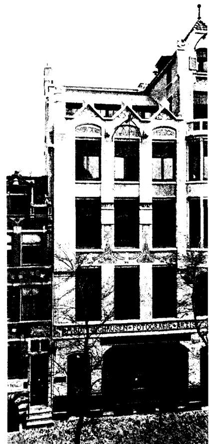
▲ Afb. 17 G. van Arkel, 'Gebouw Helios'. Spui 15, Amsterdam, 1896 (foto Bouwkundig Tijdschrift).
