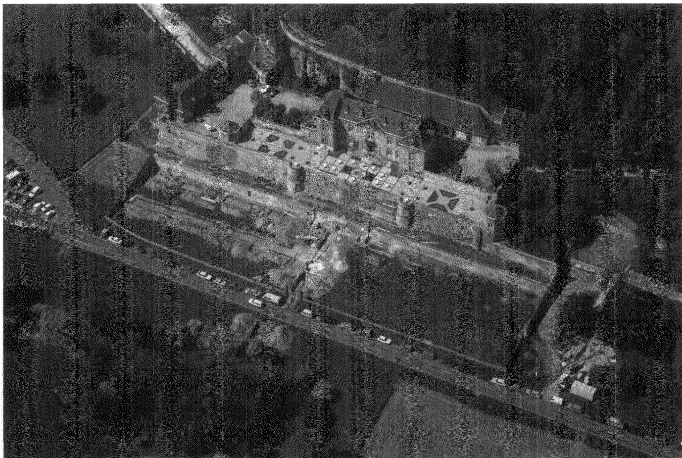
Afb. 18. Het kasteel Neercanne en de terrastuinen tijdens het bouwhistorisch en archeologisch onderzoek in 1989. Foto TU Delft, Werkgroep Restauratie.
