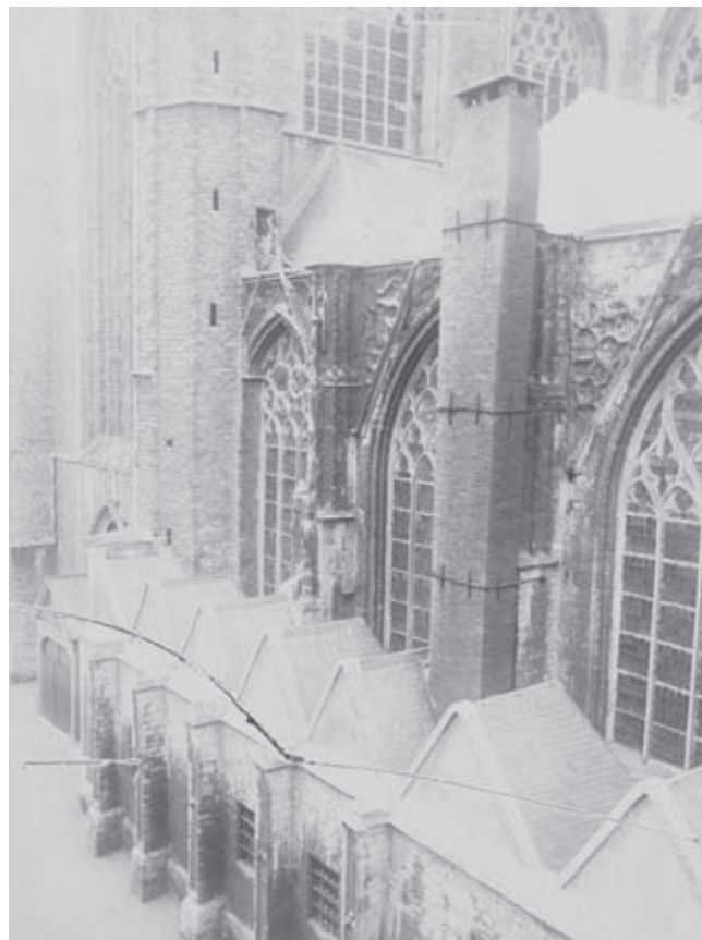
Afb. 4. Zuidgevel van het nieuwe pastoorshuis (foto RDMZ 1888)
