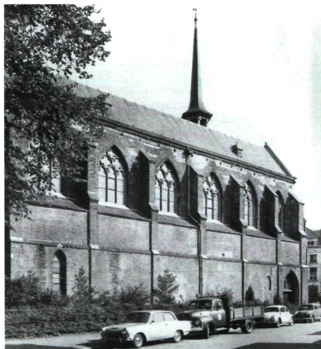
Afb. 17. (Herv.) Minderbroederskerk, voormalige kerk van de franciscanen in Roermond: zuidergevel (foto: Rijksdienst voor de Monumentenzorg, september 1965).
