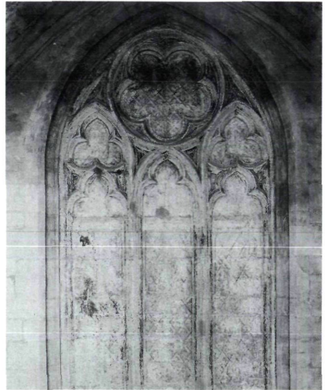
Afb. 25. Dominicanenkerk in Maastricht: blind koorvenster met restanten van beschilderde glasraamimitatie (foto: Rijksdienst voor de Monumentenzorg, juli 1916).
