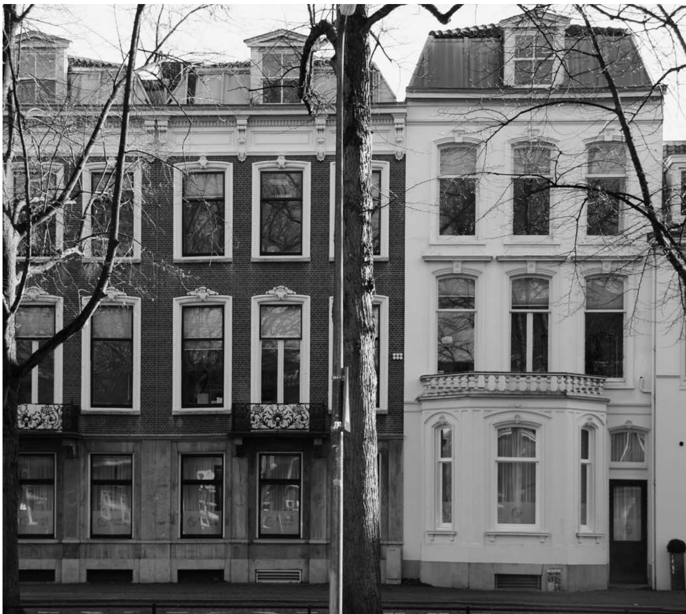
Afb. 9. Maliebaan 83 (rechts), voorbeeld van een ingebouwde koepel als koepelkamer (foto Venker en De Vries)
