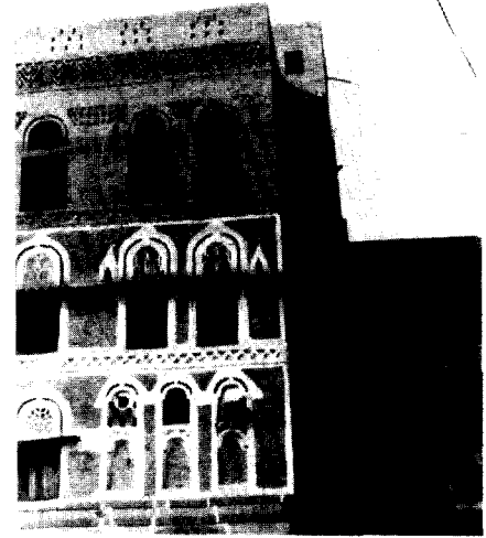
Afb. 11. Renovatie: een nieuwe verdieping op een oude woning.
