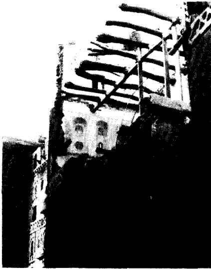
Afb. 9. Herstel van een woonhuis. Het boomstamskelet is goed zichtbaar.
