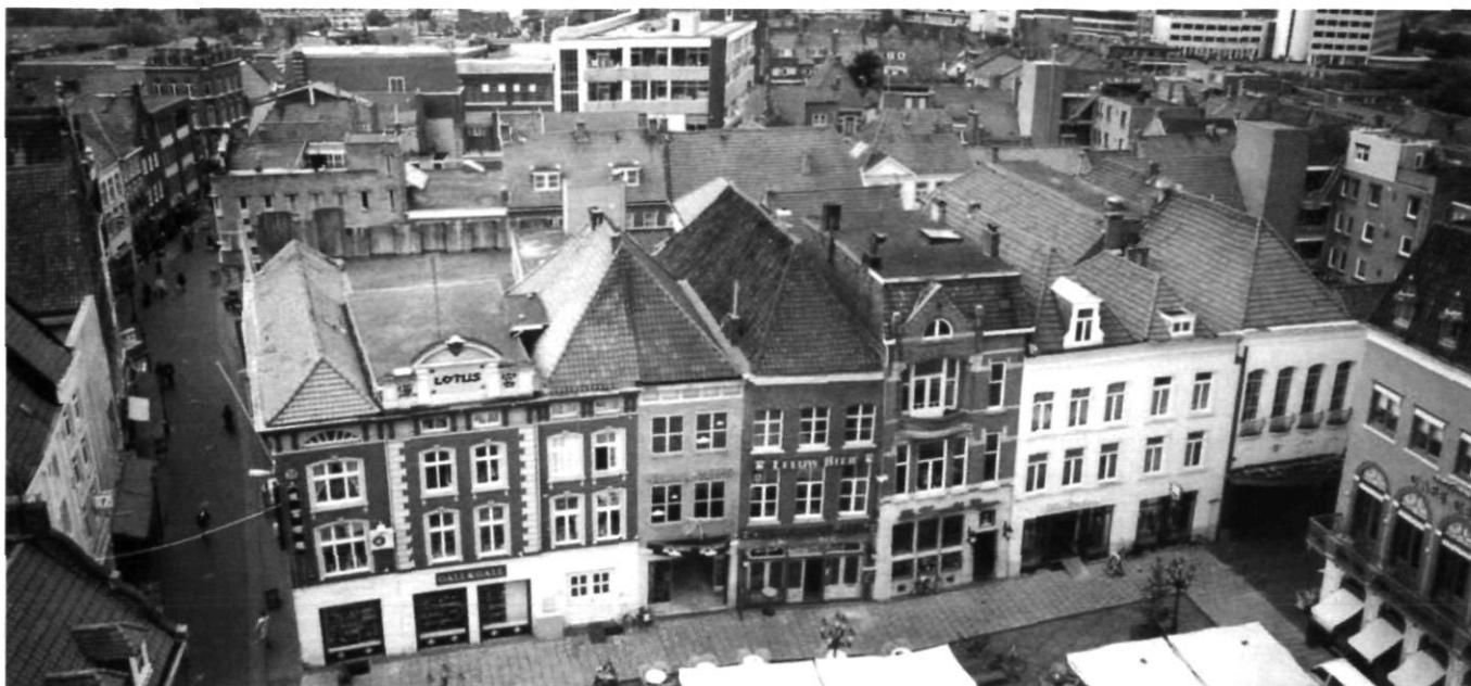
Afb. 5. Venlo, de zuidelijke gevelwand van de Markt met van links naar rechts: Markt 28 ('Lotus') – 27 – 26 – 25 – 24 – 24A – Steenstraat 1, achter deze panden de toppen van de panden aan de achtergelegen Houtstraat (foto: B.Kück en B.Dukers)
