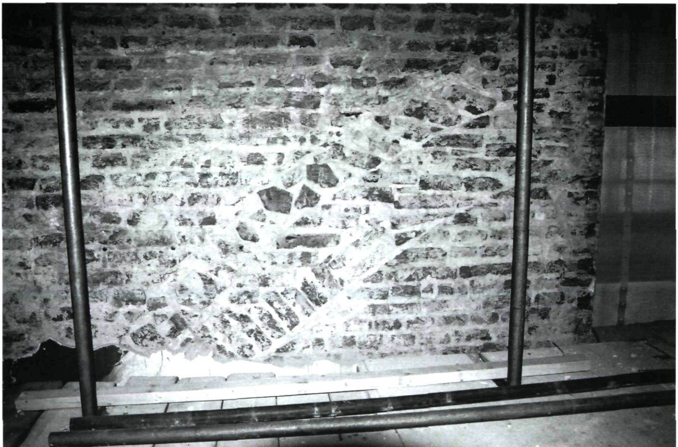
Afb. 10. In de binnenmuur van de meest oostelijke travee in de noordbeuk zijn tijdens de laatste restauratie deze bouwsporen van lage gewelven aan het licht gekomen.
