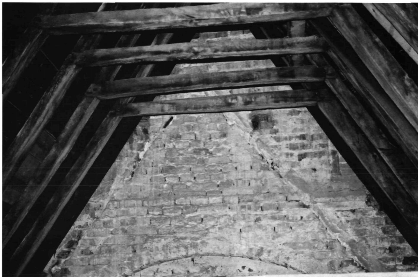
Afb. 5. Op de oostelijke torenmuur is een aftekening van de 13de-eeuwse daklijn zichtbaar.
