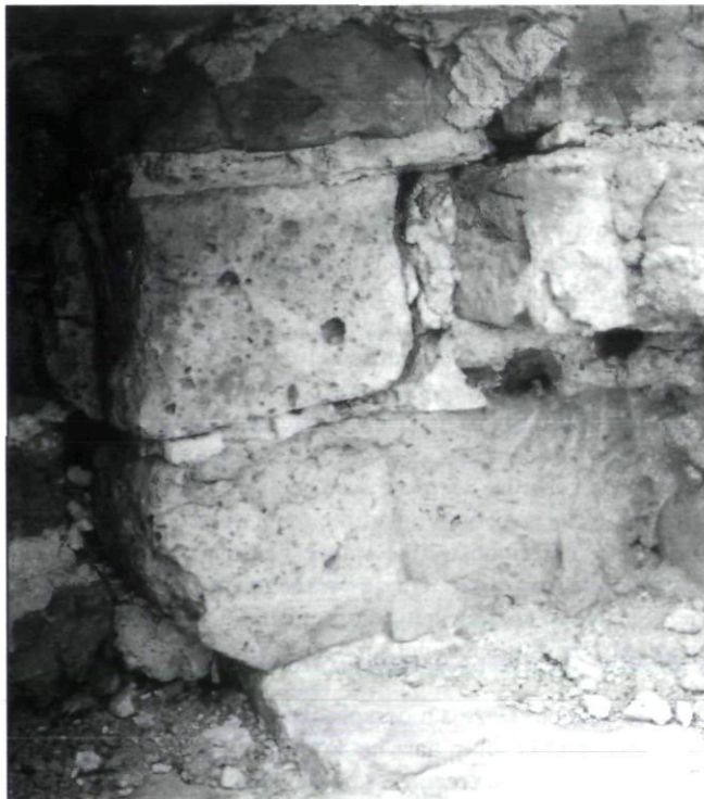
Afb. 3. Door het verwijderen van enig metselwerk naast de toren kwam de 13de-eeuwse tufstenen waterlijst in het zicht. Boven de gewelven zijn ook nog restanten hiervan behouden.
