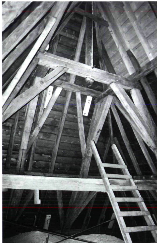
Afb. 13. De kapconstructie aan de oostzijde van de zuidbeuk.
