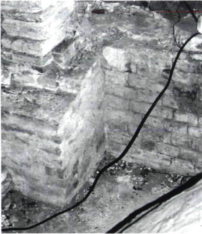
Afb. 2. Het 13de-eeuwse muurwerk in Vlaams verband ter plaatse van de versmalling tussen schip en koor.
