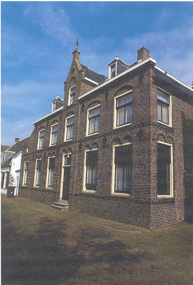
Afb. 2. Voorgevel van de pastorie te Kockengen. De ontvangstkamer bevindt zich rechts van de voordeur. In de zijgevel is langs de raampartij een bouwnaad zichtbaar (foto: SRAL Maastricht).
