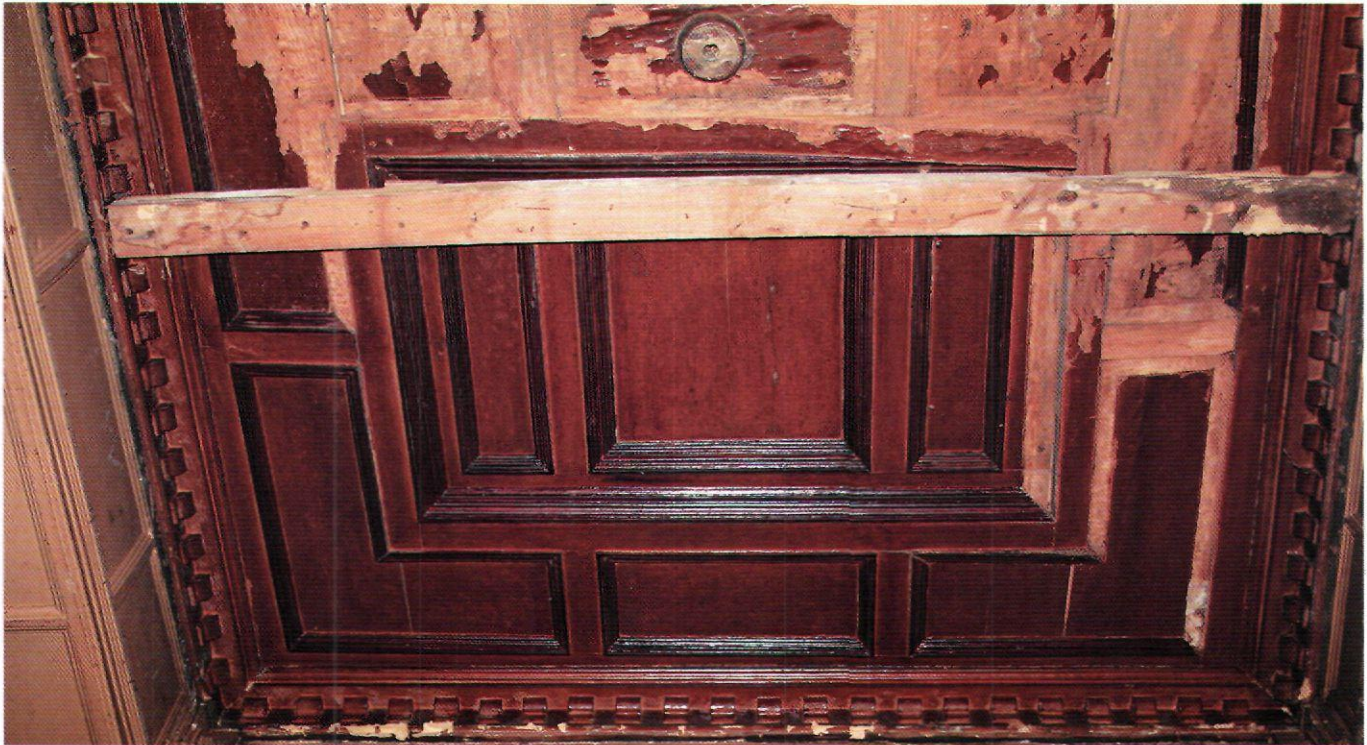
Afb. 24. Warmoesstraat 145, Amsterdam. Detail van het bewaarde middendeel van het zestiende-eeuwse cassetteplafond in het achterhuis (foto BMA)
