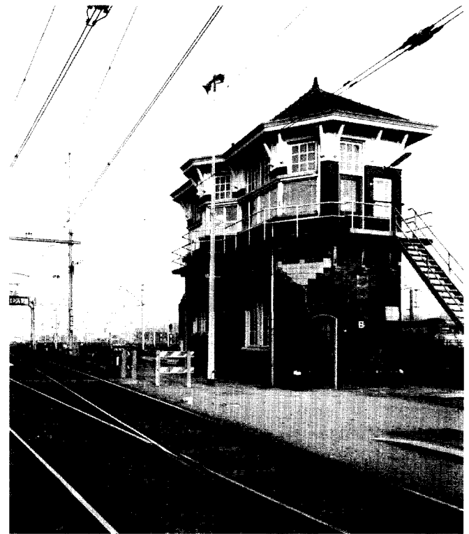
Afb. 34. Seinhuys, station Roosendaal in 1993. Een van de vele spoorwegobjecten die de in 1981 door de KNOB ingestelde Werkgroep Spoorwegmonumenten inventariseerde. (Foto RDMZ)
