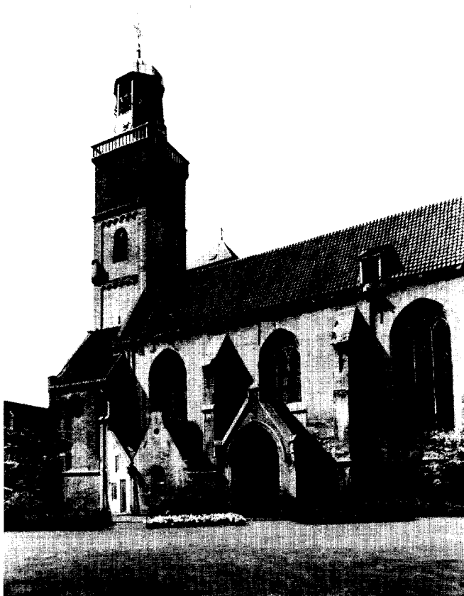
Afb. 9. Nicolaaskerk te Utrecht rond 1965. De bepleisterde zuidgevel met het aangebouwd portaalje. (Foto RDMZ)
