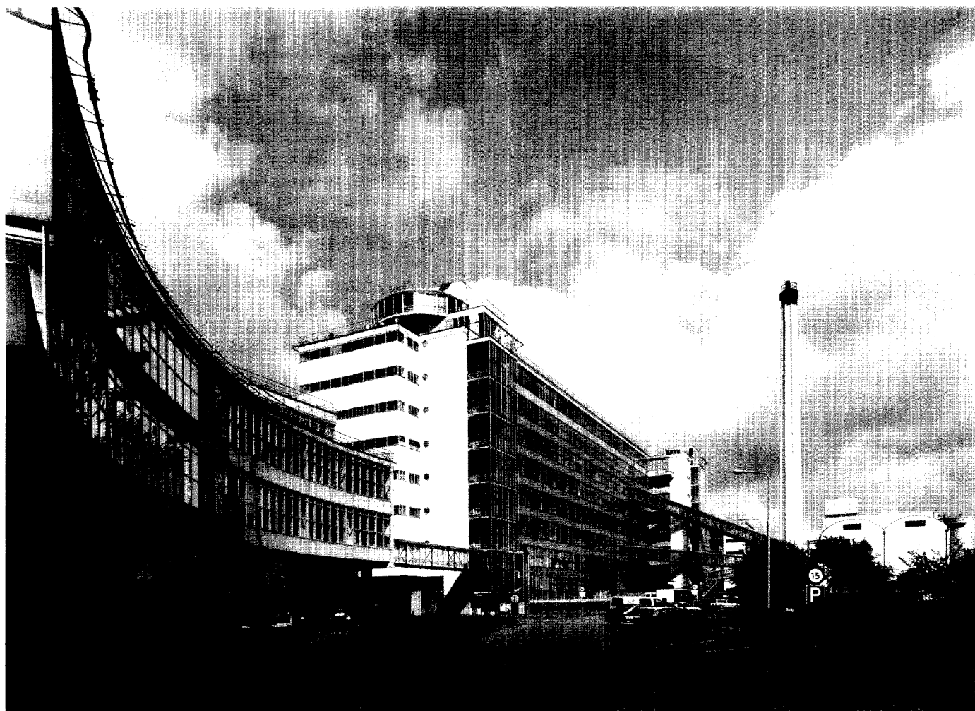
Afb. 37. Van Nellefabriek te Rotterdam in 1994. Deze als voorbeeld van het Nieuwe Bouwen beroemd geworden fabriek werd ontworpen door de architecten J.A. Brinkman en L.C. van der Vlugt. (Foto RDMZ)
