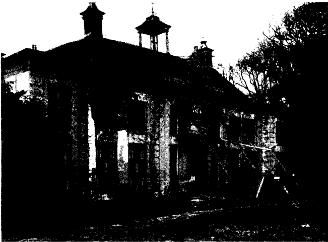
Afb. 11. Landhuis Beeckesteyn te Velsen in 1958, toen het onbewoond en zwaar vervallen was. Het huis en de bijgebouwen dreigden te worden afgebroken. (Foto RDMZ)
