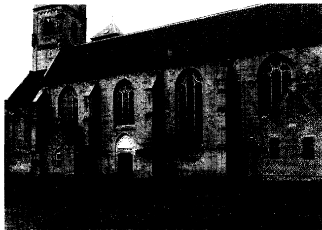
Afb. 10. Nicolaaskerk te Utrecht in 1981. De zuidgevel is ontleisterd en het portaalje is verwijderd. (Foto RDMZ)
