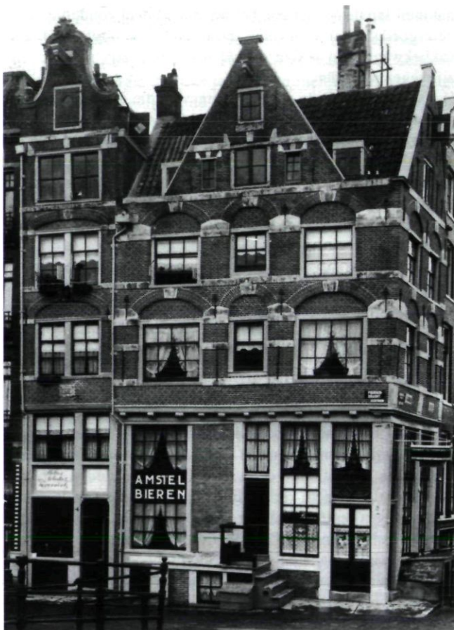
Afb. 6 Amsterdam, Prinsengracht 2, voorgevel in 1956 na de restauratie van A.A. Kok (Archief Rijksdienst voor de Monumentenzorg 1956)
