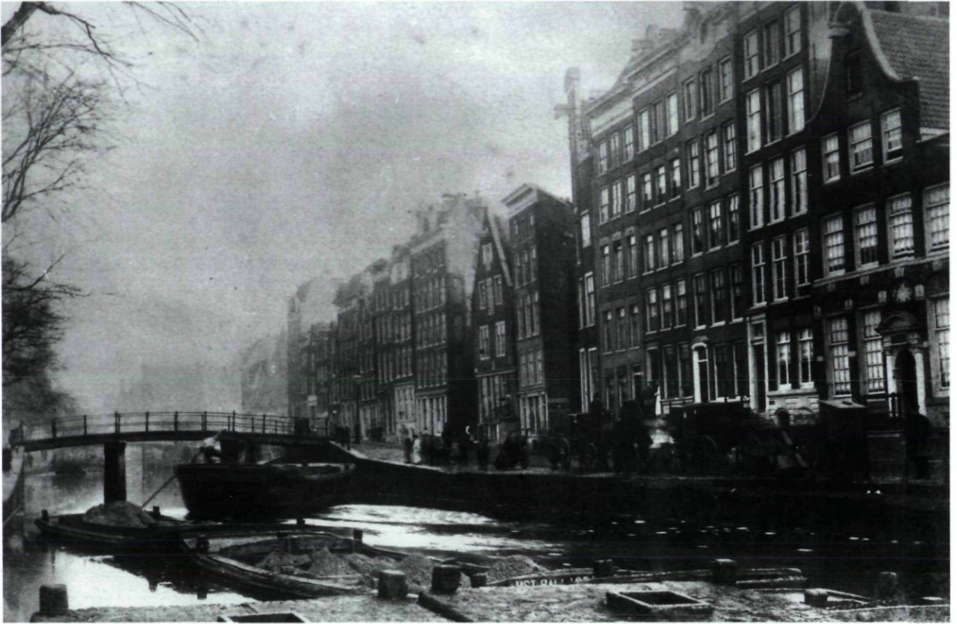
Afb. 3 Amsterdam, Nieuwezijds Voorburgwal 75, uiterst rechts, e.v., voorgevel voor de restauratie van Jan de Meijer (Archief Rijksdienst voor de Monumentenzorg z.j.)
