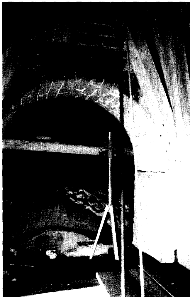
Afb. 11. Doorgang vanuit de verdieping boven de torenkapel naar de gewelven van het schip, gezien vanuit de toren (foto F. Haans 1998)
