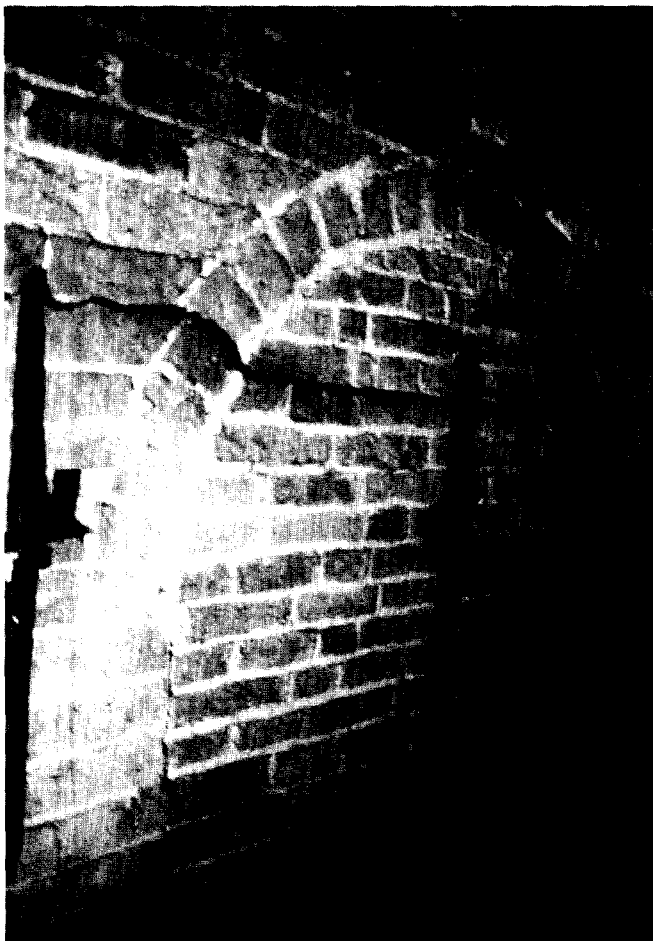
Afb. 10. Gedichte doorgang in de noordwand van de toren tussen de voormalige zolder van nevenruimte en de ruimte boven de torenkapel (foto F. Haans 1998).
