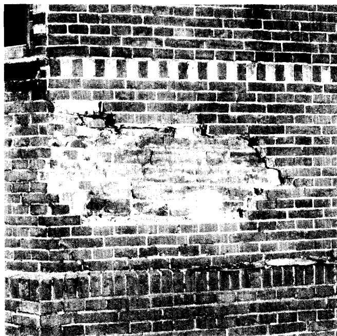
Afb. 4. Gat in de omklamping bij het koor, met achter de hier halfsteens dunne klamp de rond verlopende middeleeuwse sluitingsmuur (foto A. v.d. Wal, 1984 RDMZ)
